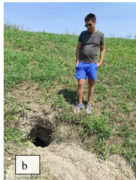
Slika 6.6 Životinjske nastambe na pokosu nasipa: (a) krtičnjaci; (b) jazbina
