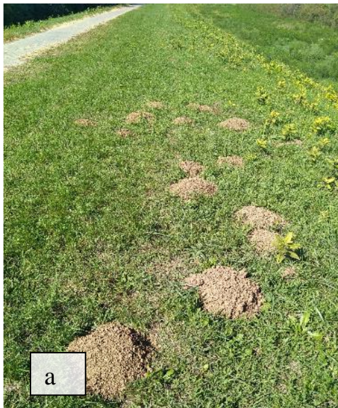
Slika 6.6 Životinjske nastambe na pokosu nasipa: (a) krtičnjaci; (b) jazbina
