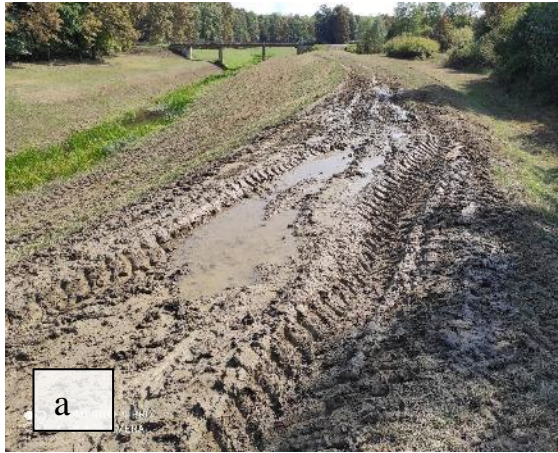
Slika 6.5 Destruktivno djelovanje vozila na: (a) kruni nasipa; (b) pokosu nasipa
