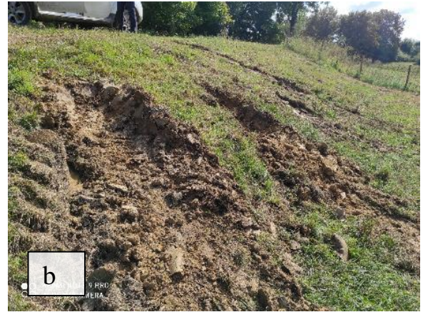
Slika 6.5 Destruktivno djelovanje vozila na: (a) kruni nasipa; (b) pokosu nasipa
