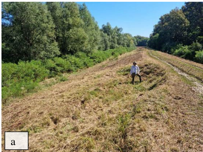
Slika 6.4 Klizište na nasipu: (a) trenutno neaktivno rotacijsko klizište; (b) recentno klizište s vidljivom glavnom pukotinom
