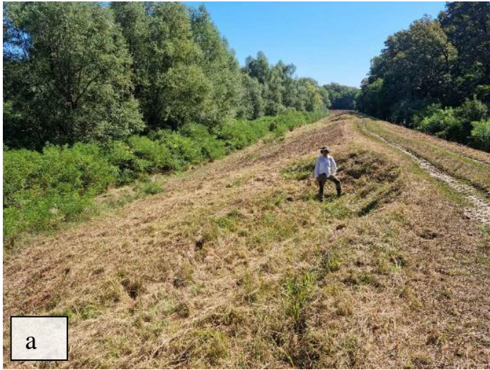
Slika 6.4 Klizište na nasipu: (a) trenutačno neaktivno rotacijsko klizište; (b) recentno klizište s vidljivom glavnom pukotinom
