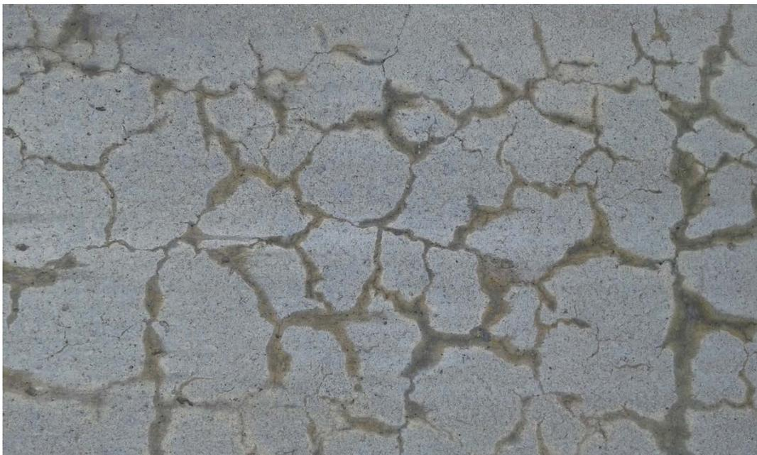
**Slika 5. 1** Alkalno–silikatna reakcija u betonu (MIT Concrete Sustainability Hub, 2009).
