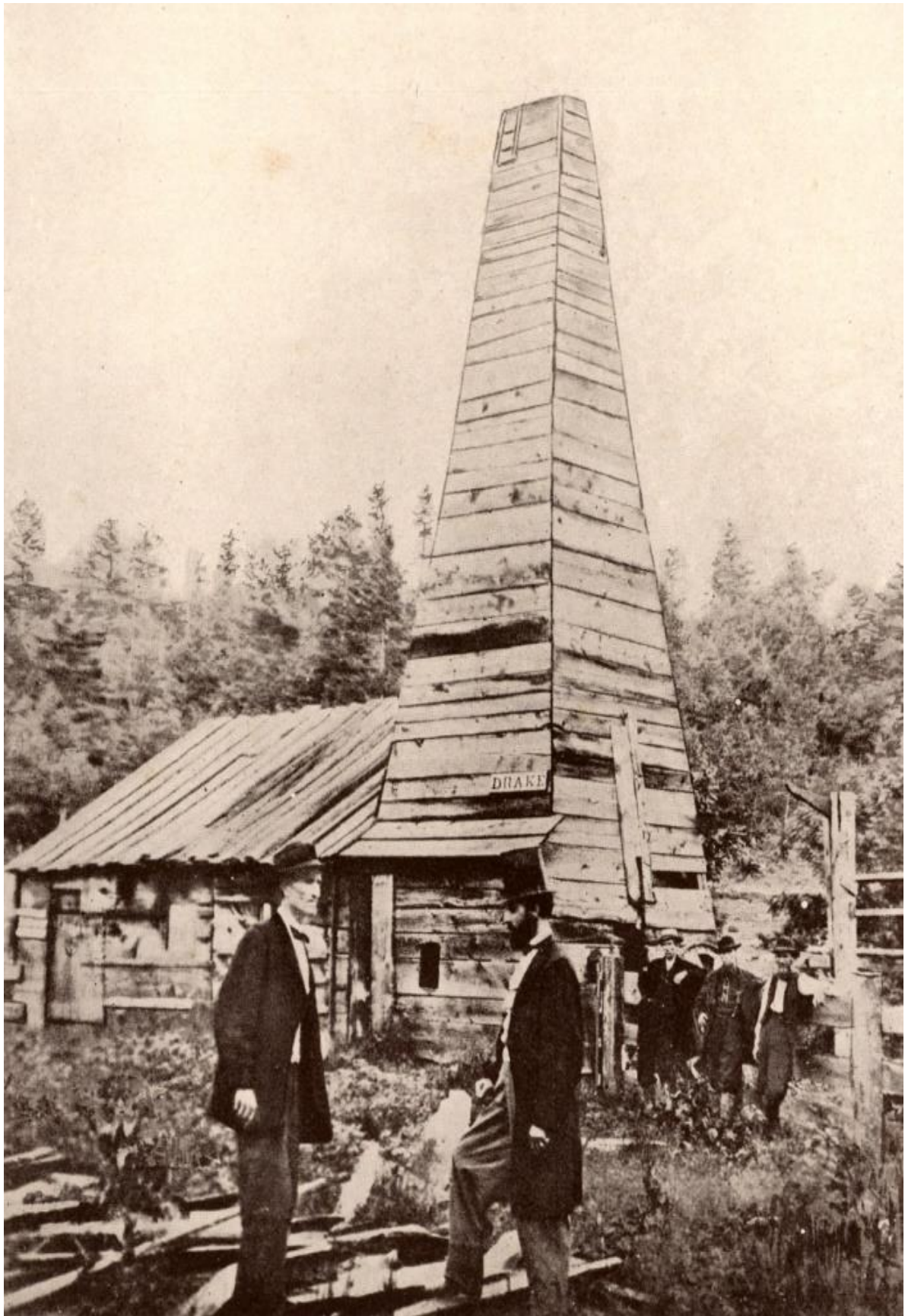
Slika 1-1. Toranj za udarno bušenje s drvenom konstrukcijom Edwina L. Drakea (britannica.com, 2015)
