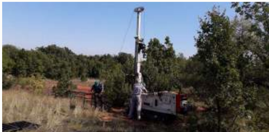
Slika 7: Bušački radovi na ležištu Mamutovac u okviru projekta REEBAUX
