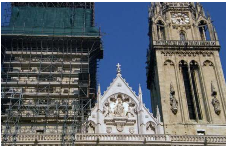
Slika 2-7 Obnovljeni timpan (HKV, 2020)
