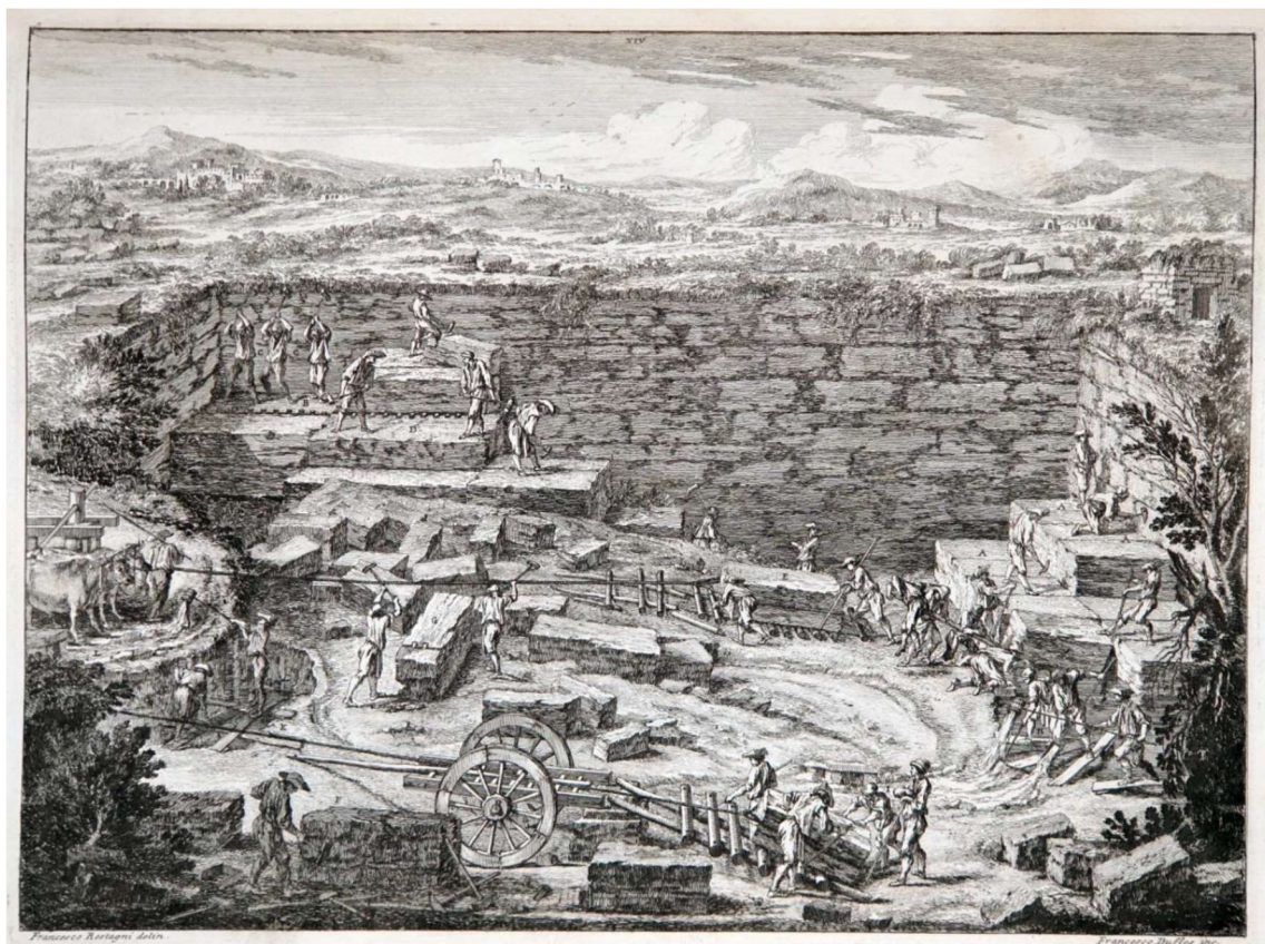
Slika 3-13 Prikaz rada u kamenolomu travertina (Holtzer, 2019)
