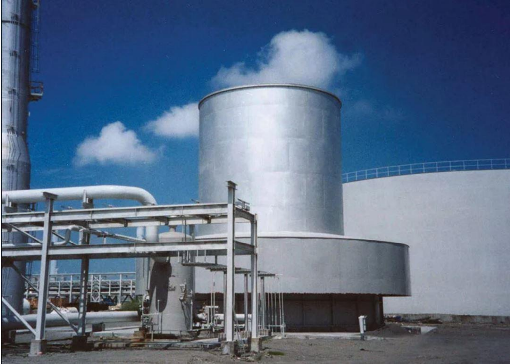
Slika 4-4. Zatvorena baklja (Zeeco, 2022)
