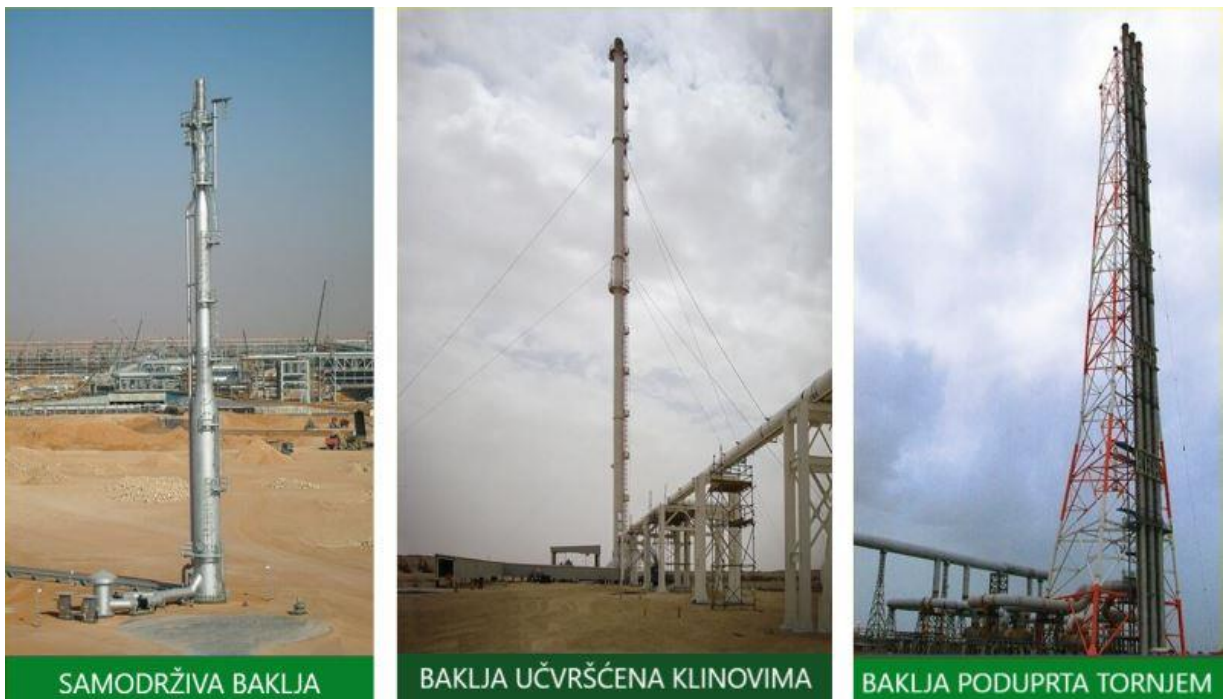
Slika 3-2. Tipovi konstrukcije uspravnih baklji (The piping talk, 2021)
