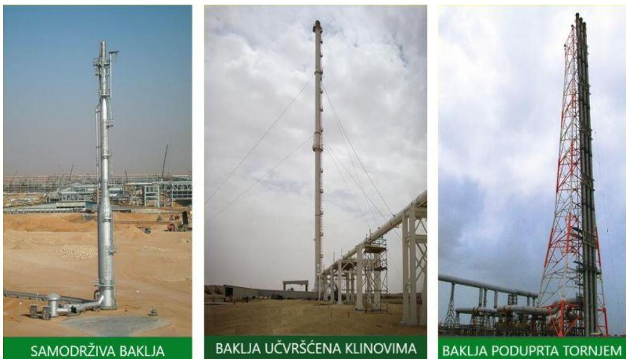
**Slika 3-2.** Tipovi konstrukcije uspravnih baklji (The piping talk, 2021)
