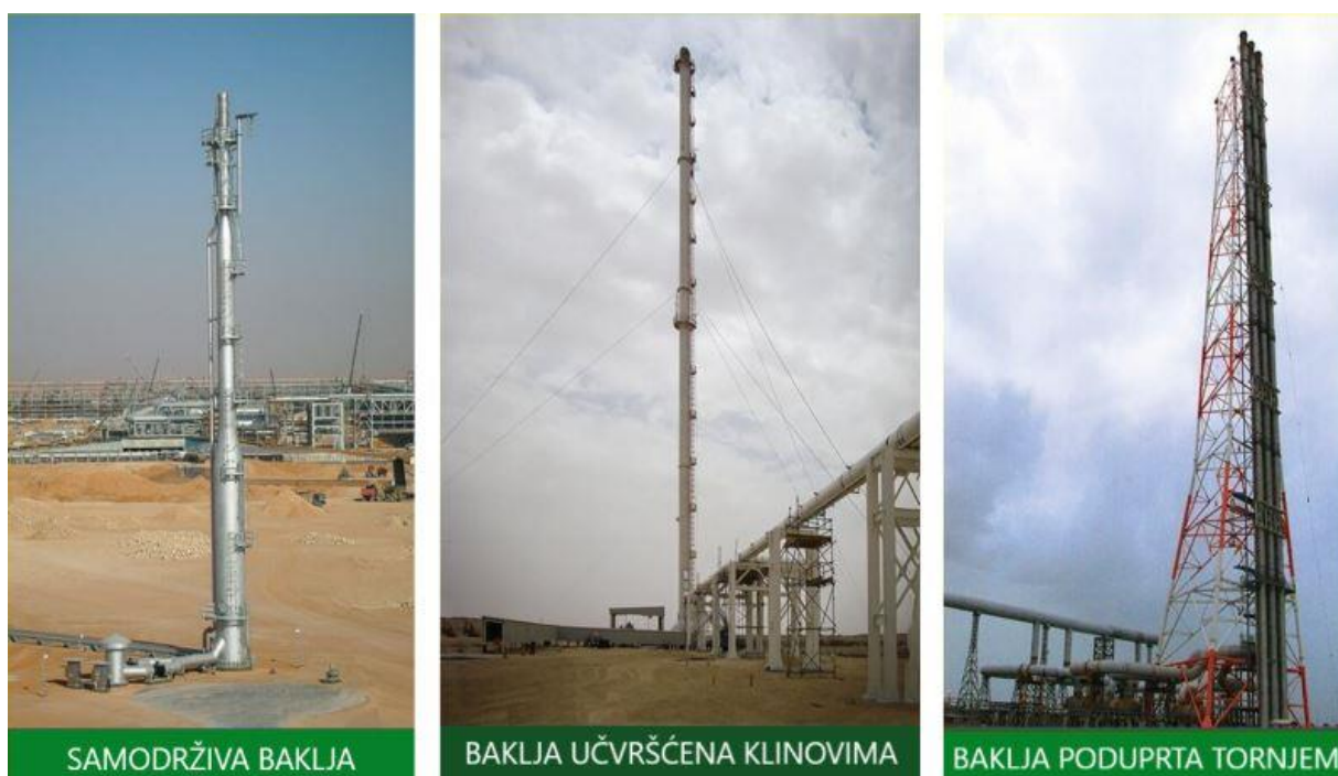
Slika 3-2. Tipovi konstrukcije uspravnih baklji (The piping talk, 2021)
