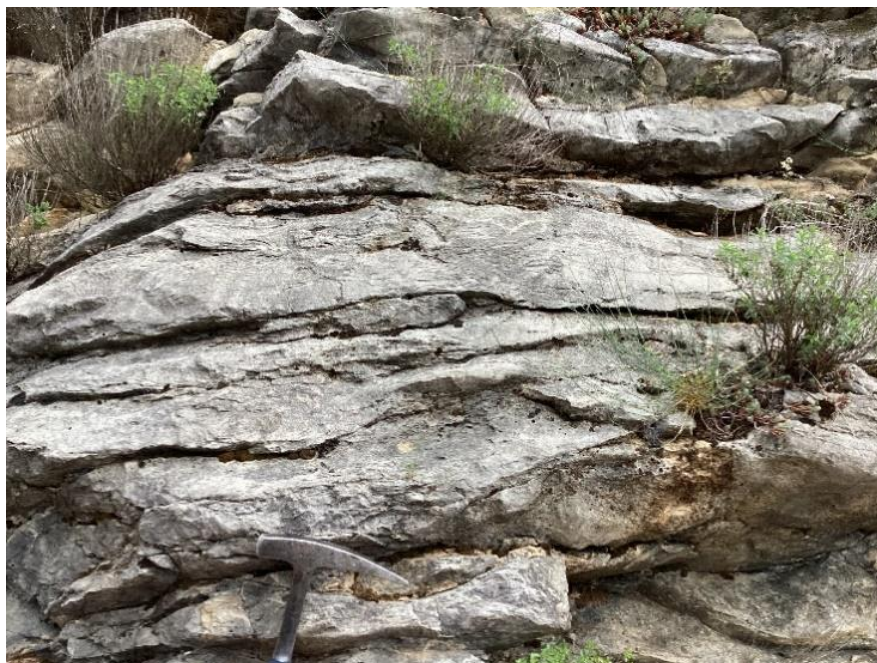
Slika 5-2. Slojevi jasno izraženih oštih valovitih ili nepravilnih slojnih ploha
