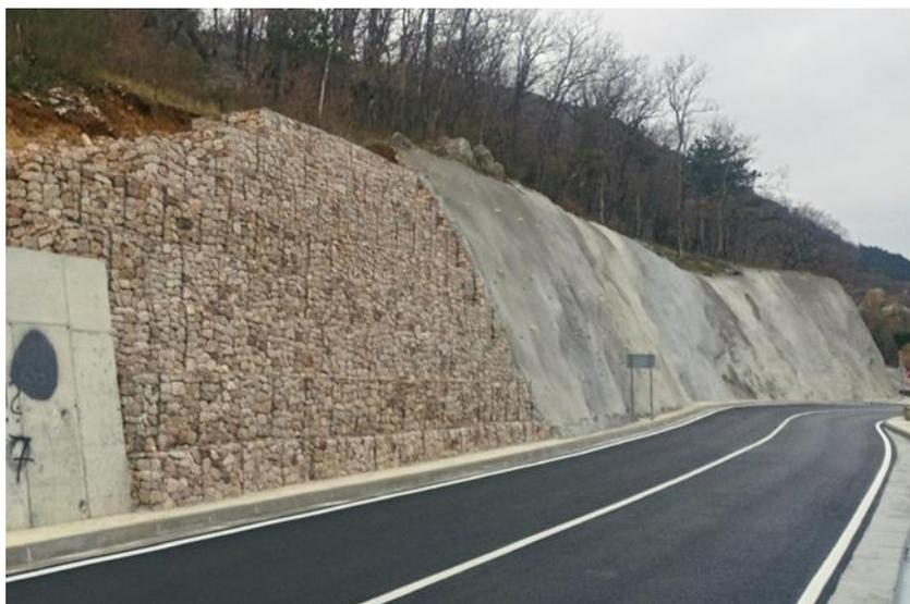
**Slika 5-1.** Gabionski zid uz prometnicu (Geotech, 2011)
