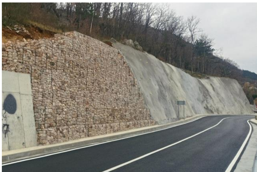
Slika 5-1. Gabionski zid uz prometnicu (Geotech, 2011)
