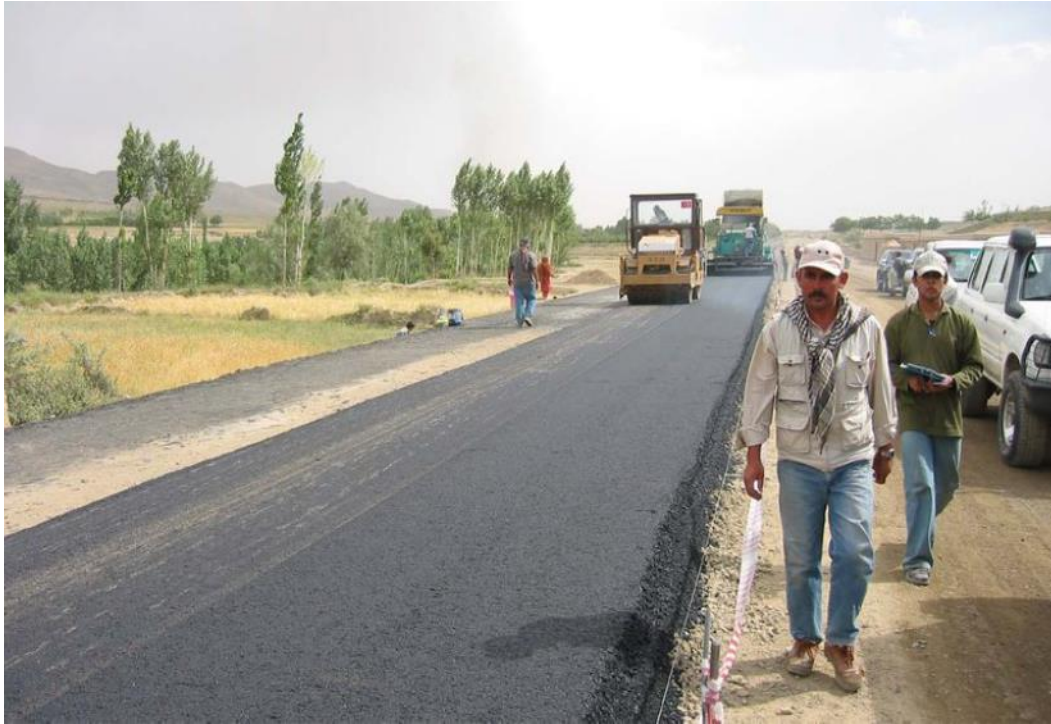
Slika 5-4. Kameni mulj kao sastojak u asfaltu (Papantonopoulos i sur., 2007)
