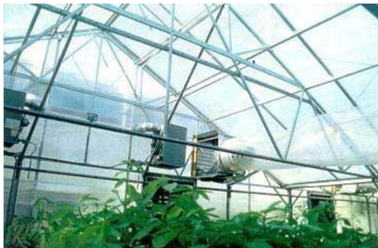
Slika 4-2. Jet-fan sustav (usgr.com, 2019)
