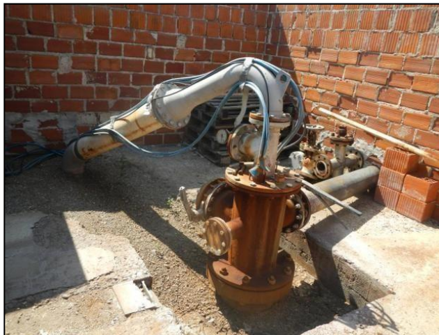
Slika 5-1. Nadzemni dio bušotine N-1 (Elaborat zaštite okoliša u postupku ocjene o potrebi procjene utjecaja na okoliš eksploatacije geotermalne vode za energetske potrebe na budućem eksploatacijskom polju "Sveta Nedelja", 2018)
