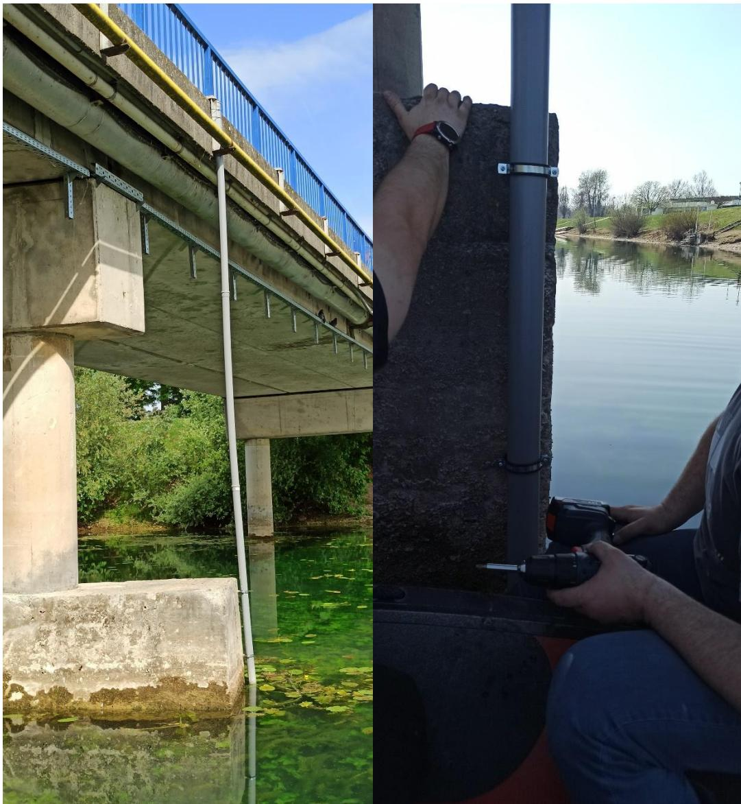
Slika 3.3 Plastična cijev učvršćena na tri mesta za konstrukciju mosta na Jarunu. X=5071901,01 ; Y=454279,26
