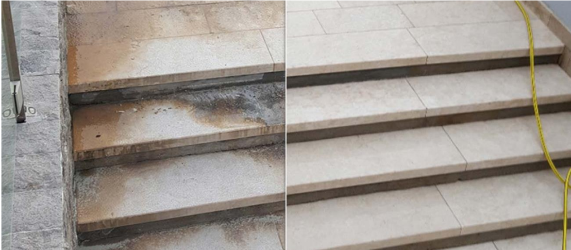
Slika 7-7. Prikaz ploča ugrađenih na vanjsko stepenište prije i poslije tretmana pjeskarenja
