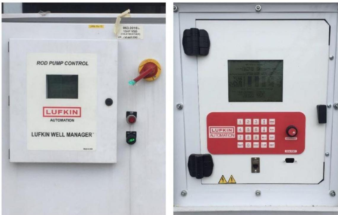
**Slika 3-1.** RPC - upravljački uređaj (INA d.d., 2015)
