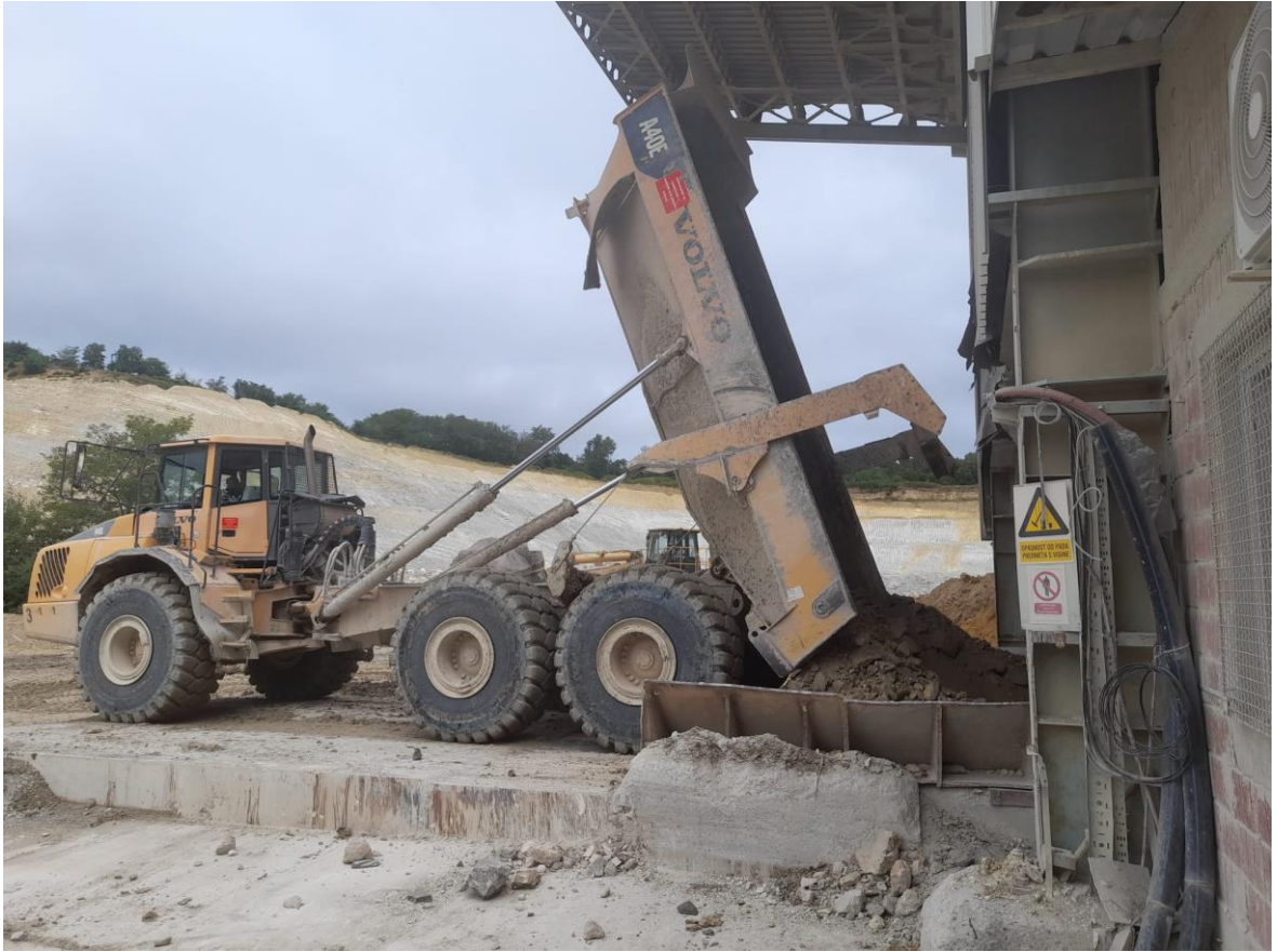
Slika 7-3 Istovar sirovine damperom u usipni koš oplemenjivačkog postrojenja
