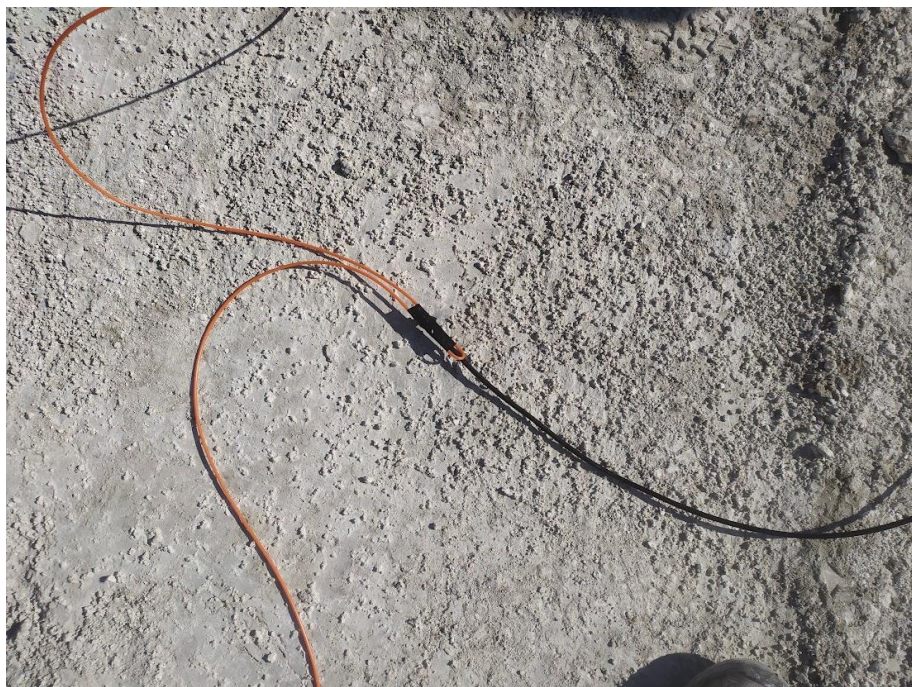
Slika 6-7 Paljenje minskog polja
