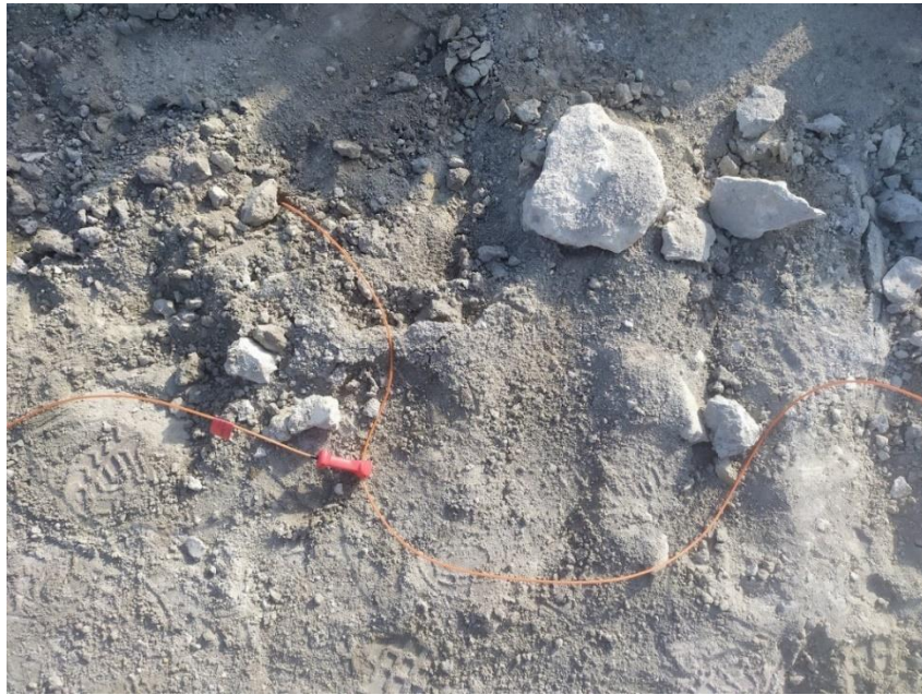
Slika 6-4 Spajanje minskih bušotina u redu
