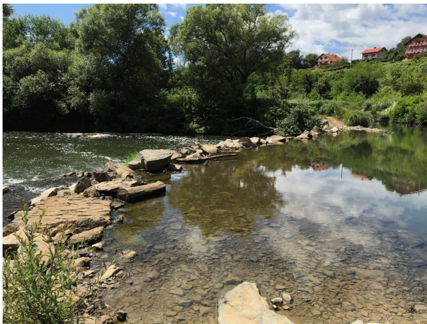
Slika 4-44. Antropogena struktura nasipa na rijeci Glini u blizini Topuskoga koja je uzrok pojave točke prijelomnice na profilu ( \varphi - 45.2886948315848, \lambda - 15.9979474079013)
