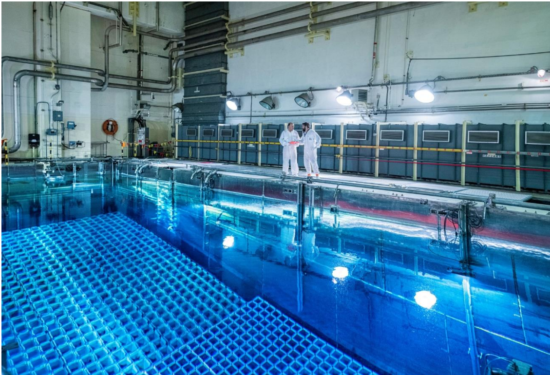
Slika 2-1. Nuklearna elektrana Krško, bazen za skladištenje ING-a ( https://www.nek.si , 2022)
