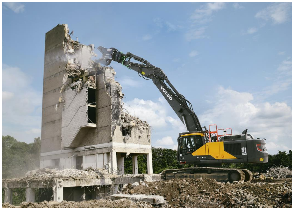
Slika 5-1. Rušenje objekta pomoću građevinskog stroja (Volvo, 2020)
