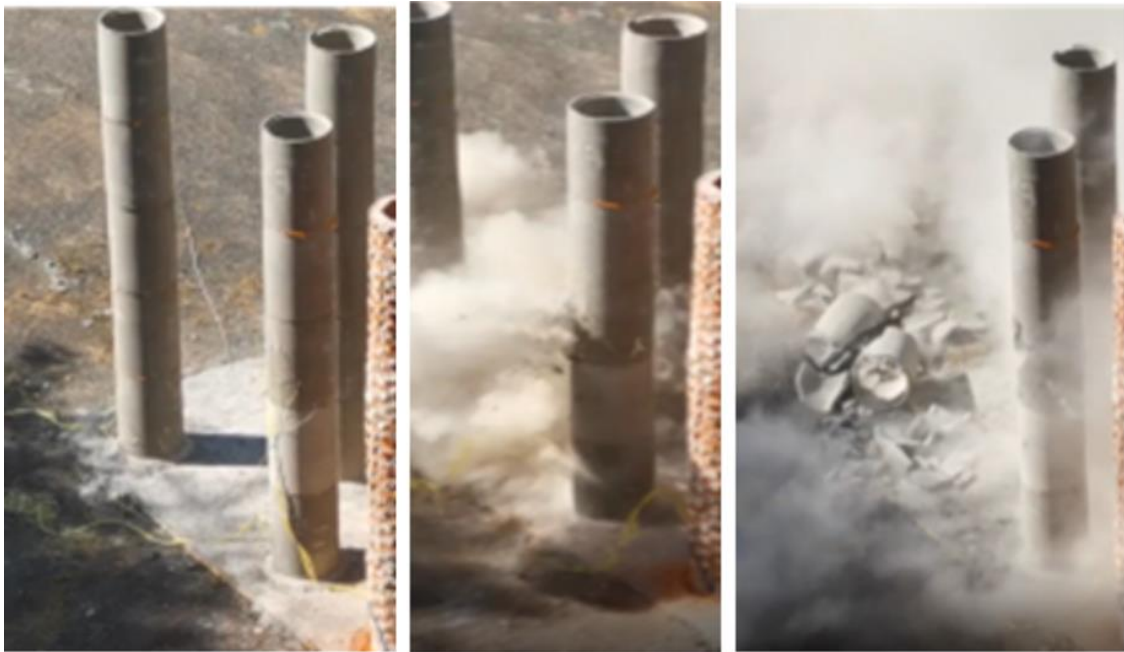
Slika 6-2. Djelomično neuspjelo rušenje dimnjaka (Katalinić et al, 2021)
