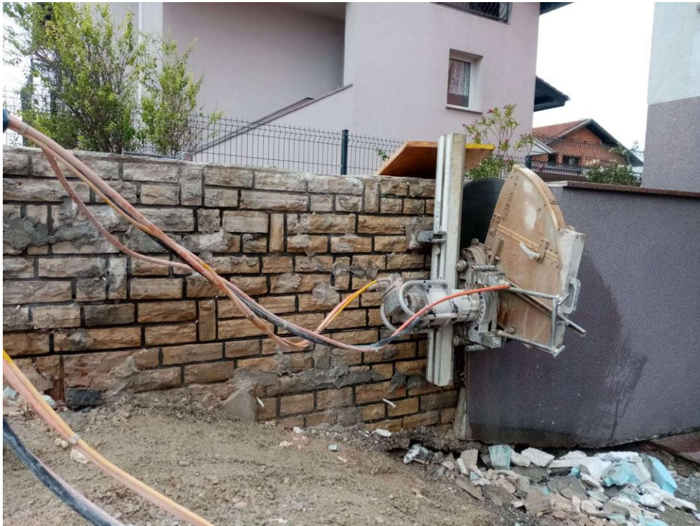
Slika 5-2. Dijamantno rezanje betonske ograde (Cro-rez, n.d.)
