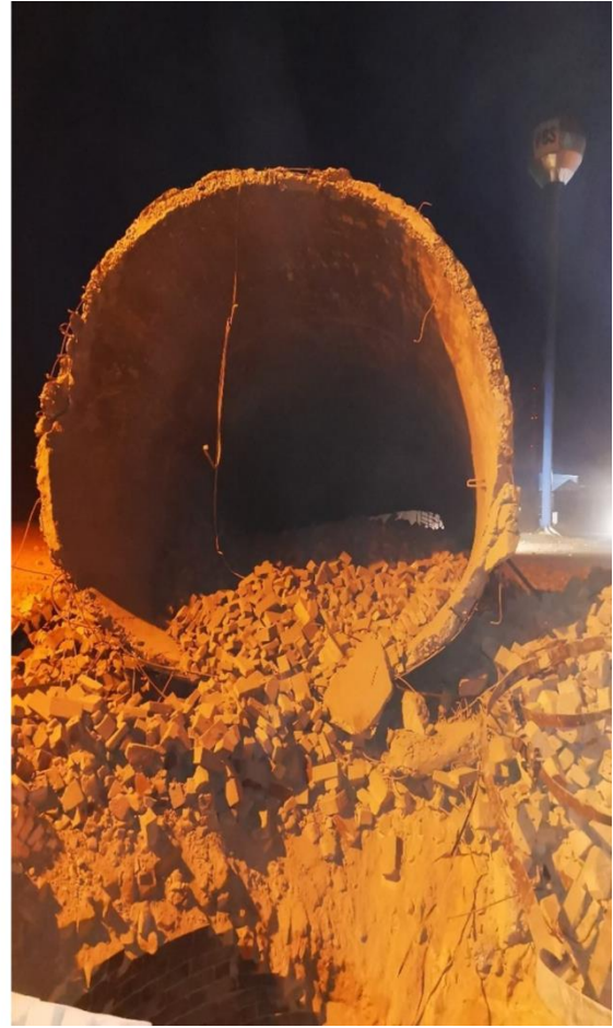
Slika 2-2. Betonski dimnjak tanke stijenke srušen eksplozivnim nabojem (Vukšić i Kosović, 2022)
