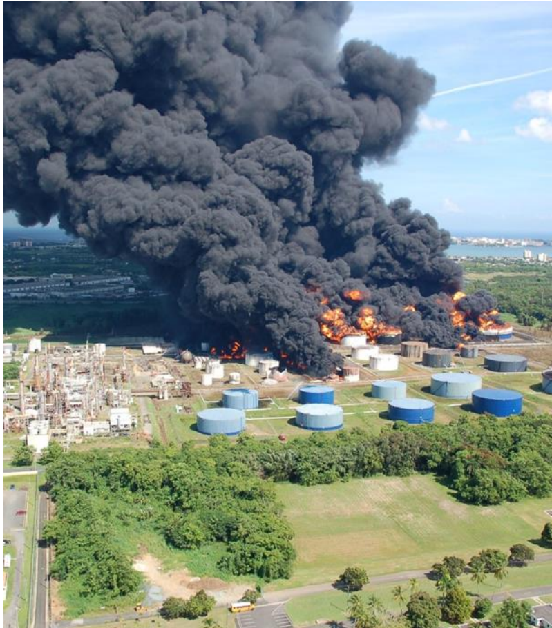
Slika 8-3. Požar u rafineriji CAPECO-a (CSB, 2015).
