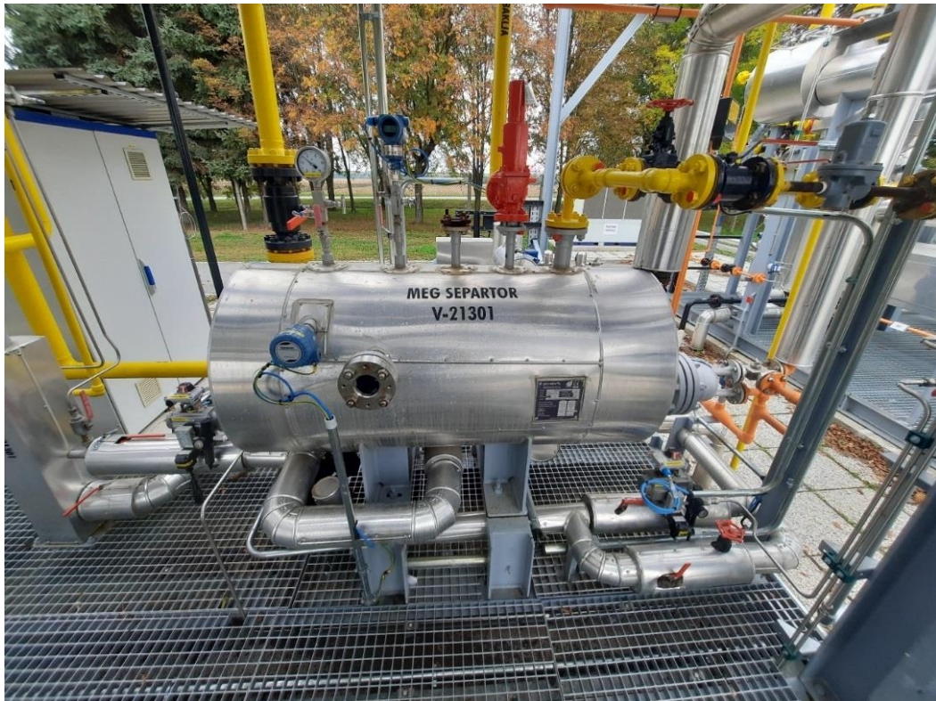
Slika 4-11. Separator za izdvajanje monoetilenglikola
