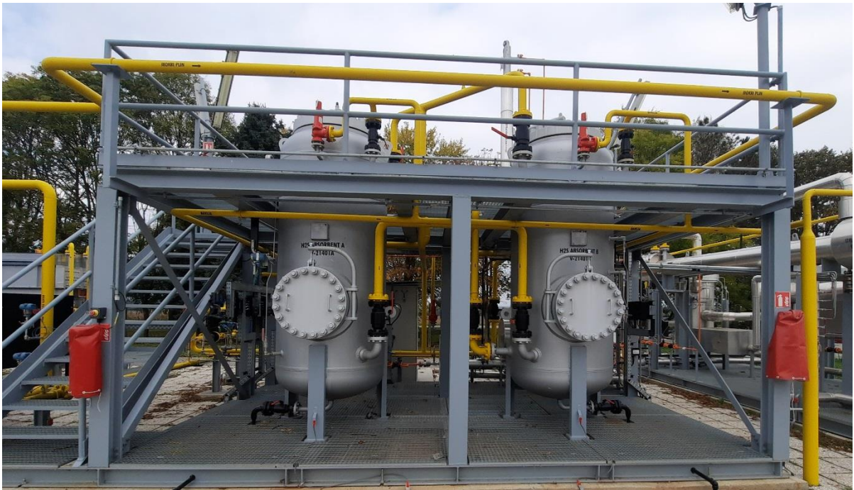
Slika 4-15. Jedinica za izdvajanje H_2S -a
