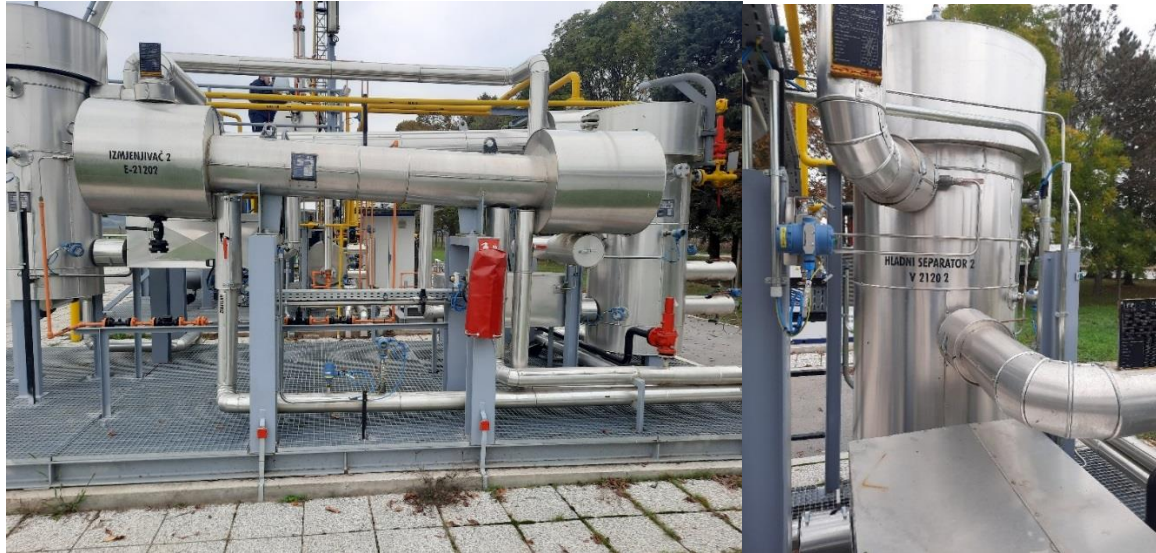
Slika 4-10. Hladnjak tj. izmjenjivač topline propan/plin (lijevo) i nisko temperaturni separator II (desno)
