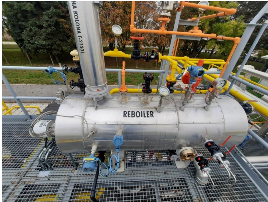
Slika 4-12. Regeneracijska jedinica MEG-a
