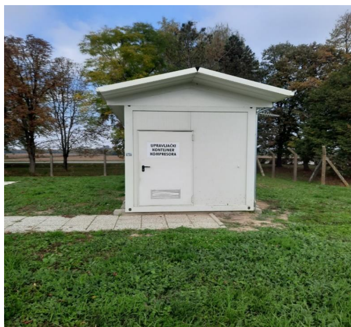
Slika 4-7. Upravljački kontejner kompresora i postrojenja za izdvajanje kiselih plinova
