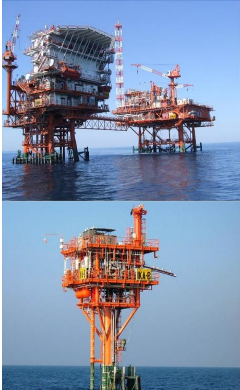
Slika 4-2. Eksploatacijska platforma Ivana A i kompresorska platforma Ivana K (gore), eksploatacijska platforma Ika B, monopod (dolje) (Farkaš Višontai et al, 2019b)
