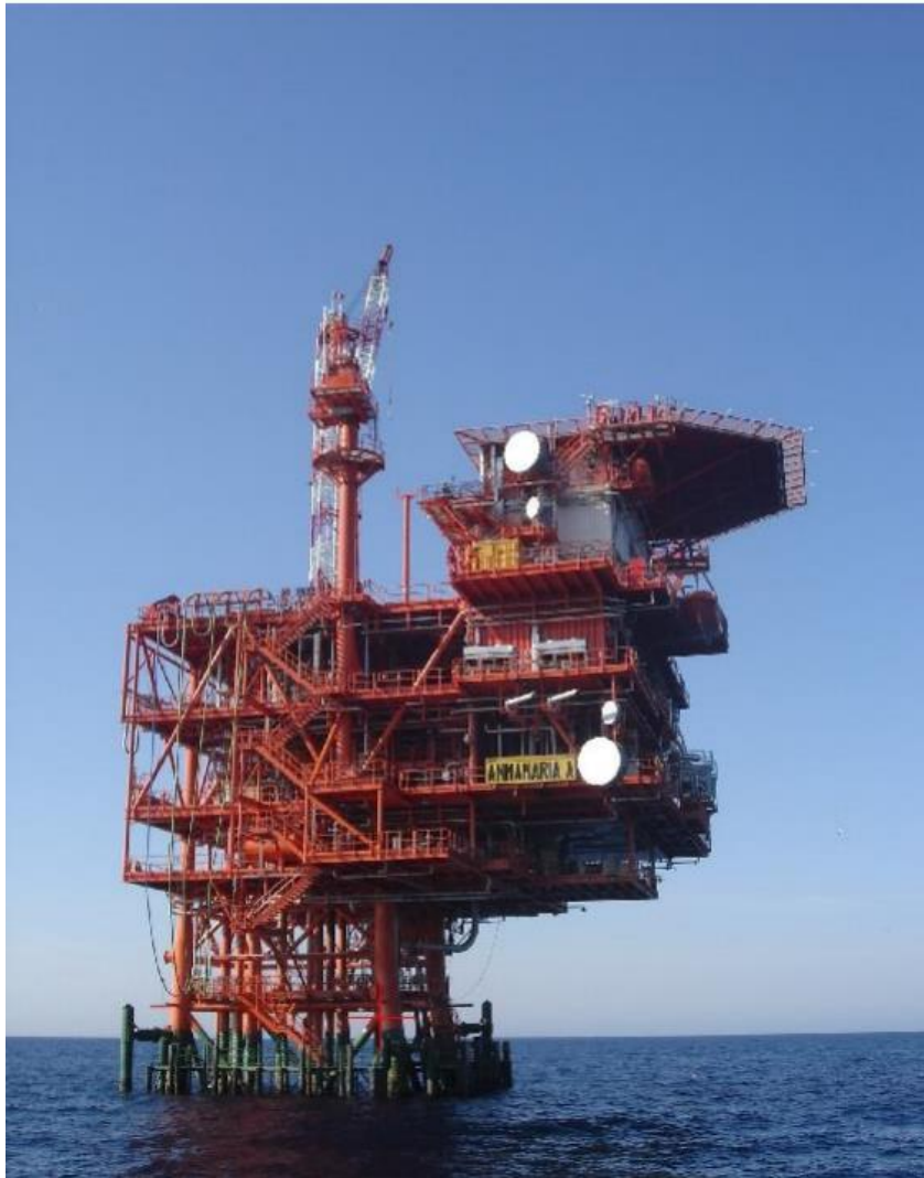
Slika 4-3. Eksploatacijska platforma Annamaria A, četiri noge (Farkaš Višontai et al, 2019b)
