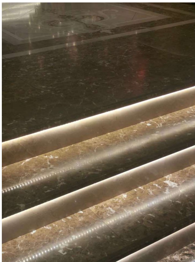
Slika 5-15 Stepenice popločene tamnim varijetetom vapnenca u sklopu Sheraton hotela u Zagrebu (foto: V. Apostolovski)
