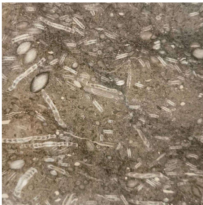
Slika 5-2 Zid robne kuće Nama u Zagrebu obložen pločama istranke (foto: V. Apostolovski)
