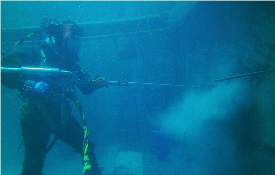
Slika 2-3. Stručni ronilac obavlja bušenje (Falch, 2018.)
