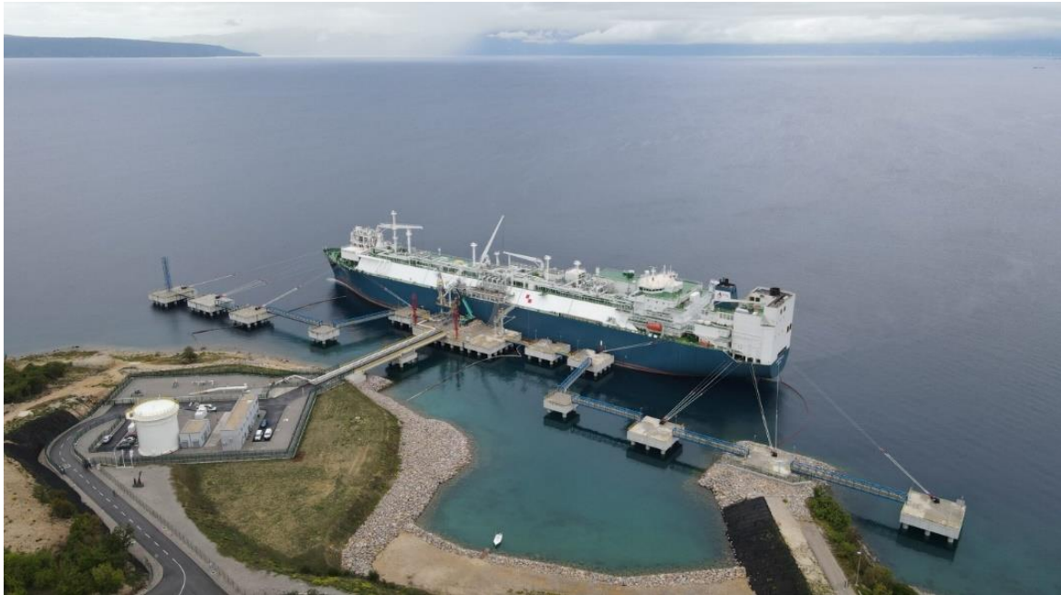
Slika 5-4. FSRU terminal LNG Croatia (LNG Hrvatska, n.d.)
