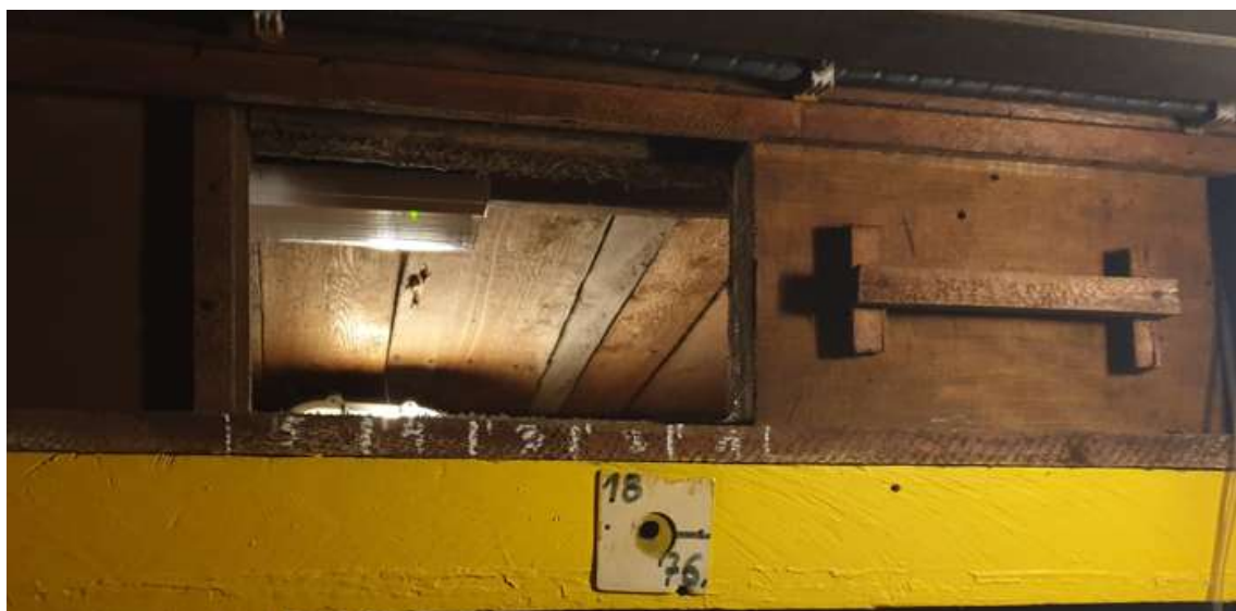
Slika 4-6. Regulacijski otvor na vjetrenim vratima
