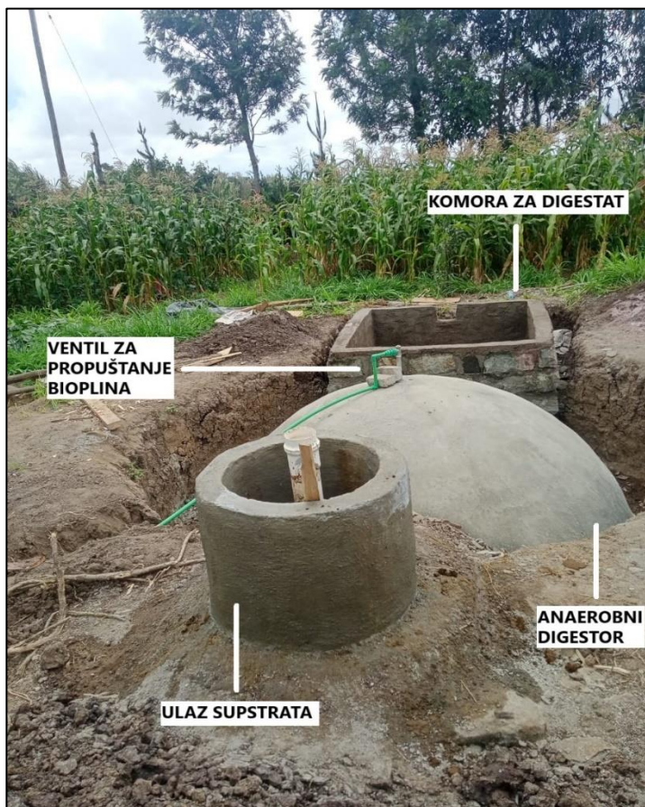
Slika 4-7. Podzemno šaržno postrojenje za proizvodnju bioplina s tri komore (Charles et al., 2006)
