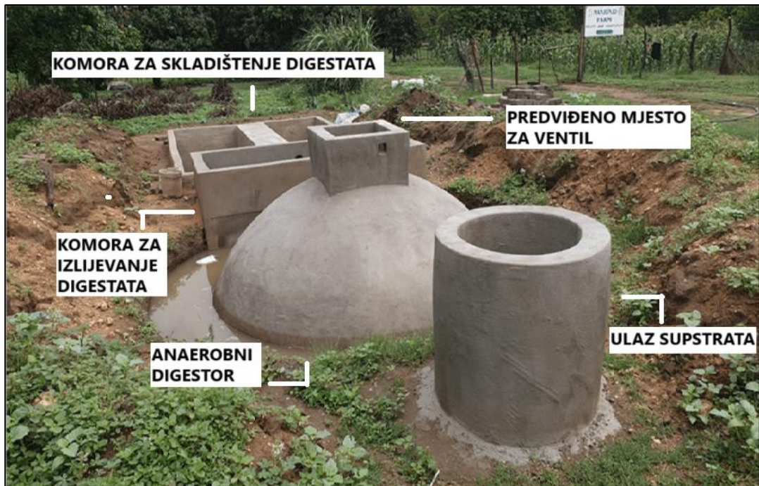
Slika 4-6. Podzemno šaržno postrojenje za proizvodnju bioplina s četiri komore (SOLAREYES, 2023)
