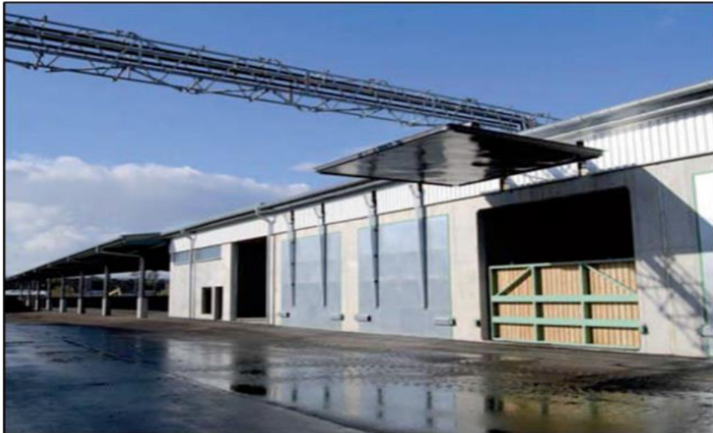
Slika 4-9. Otvor za utovar otpada na šaržnom bioplinskom postrojenju (BEKON, 2011)
