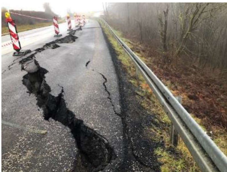
Slika 3-5. Oštećenje ceste prilikom klizanja tla uzrokovanog potresom (Tomic i dr., 2021)
