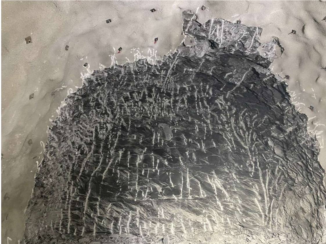
Slika 7-30. Iskop u laporu fliša na stacionaži 33+613,00
