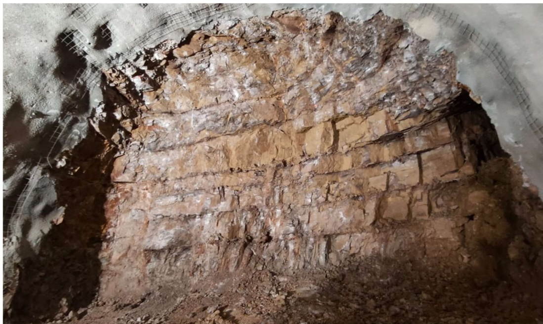
Slika 7-5. Iskop u pločastom vapnencu V. kategorije stijenske mase na stacionaži 30+667,50
