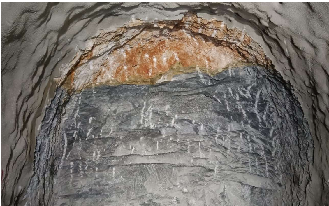
Slika 7-27. Kontakt foraminiferskog vapnenca i lapora fliša u V. kategorije stijenske mase na stacionaži 33+650,00
