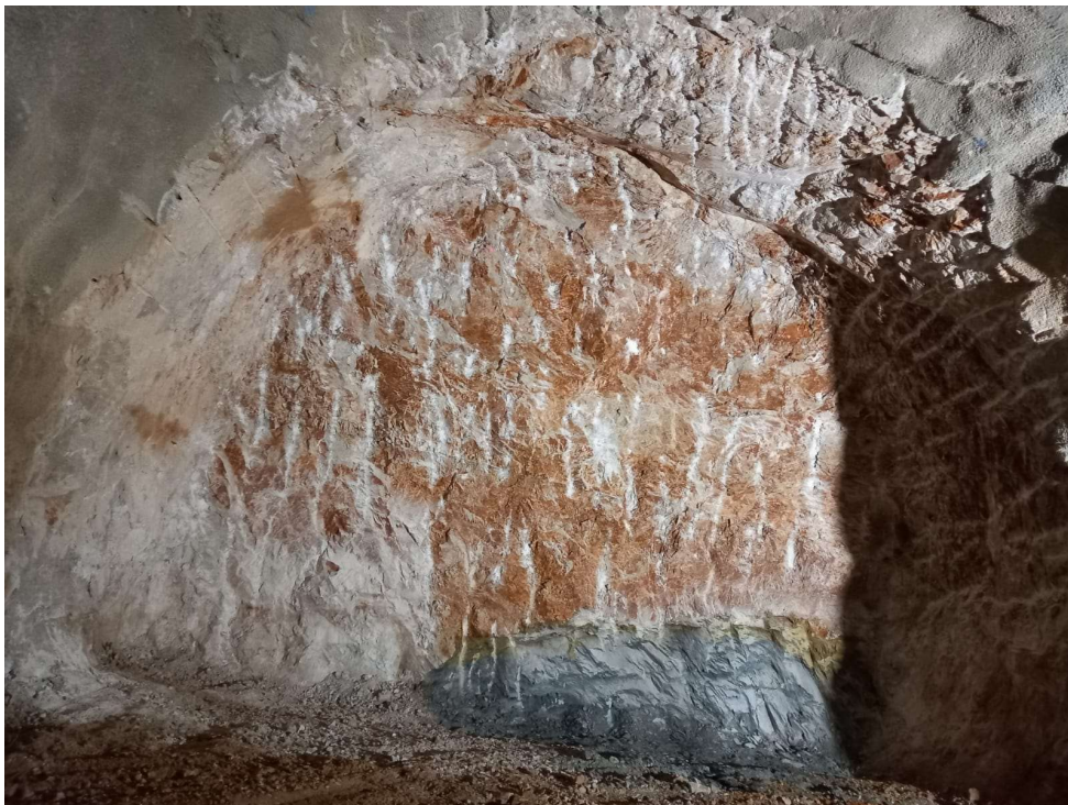
Slika 4-6. Početak kontakta na stacionaži 33+663,30 gdje se prvi puta pojavio lapor zajedno s foraminiferskim vapnencom
