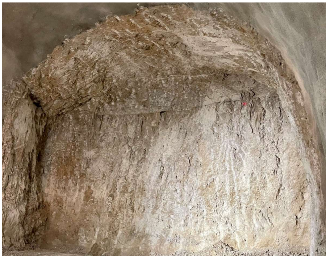
Slika 7-23. Iskop u foraminiferskom vapnencu II. kategorije stijenske mase na stacionaži 33+035,70
