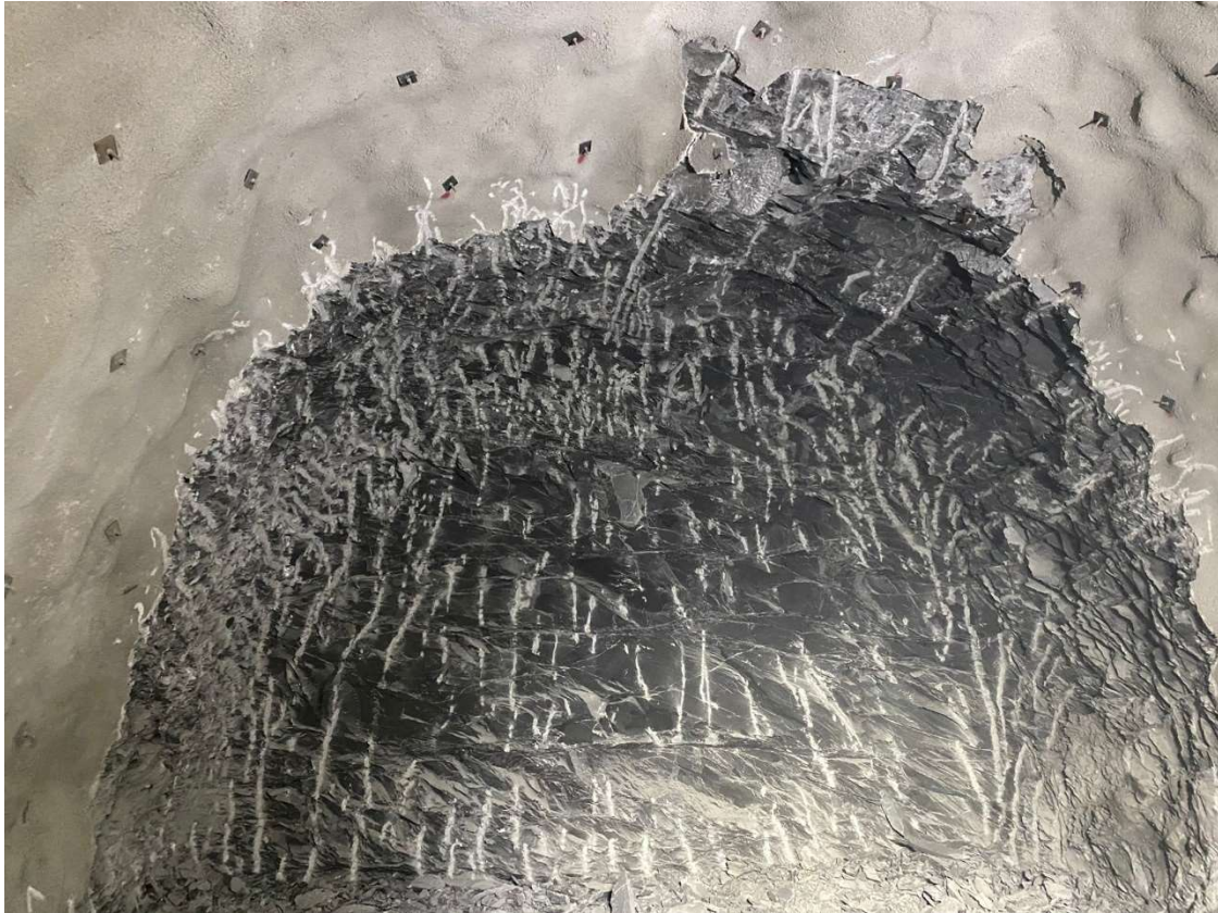
Slika 7-30. Iskop u laporu fliša na stacionaži 33+613,00
