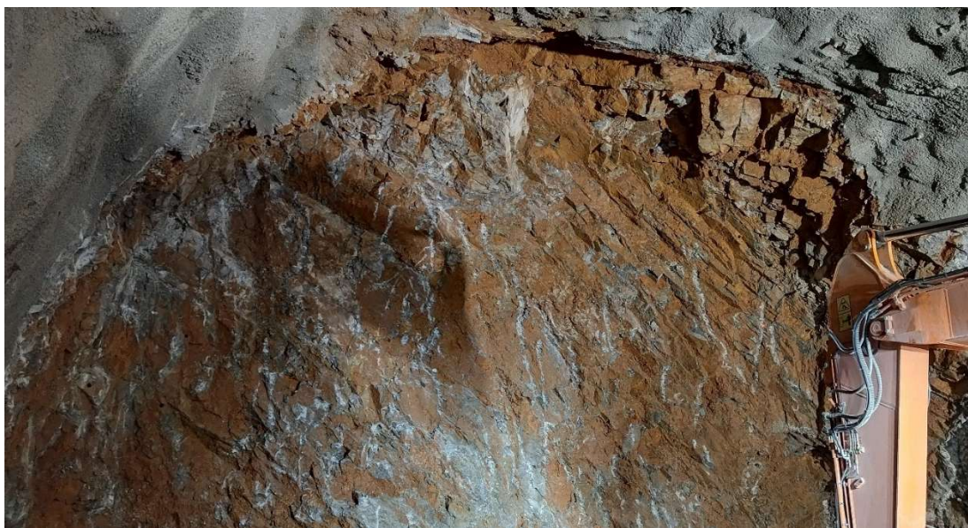
Slika 7-33. Iskop u vapnencu donje krede IV. kategorije stijenske mase na stacionaži 35+190,00
