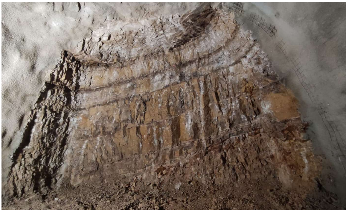
Slika 7-14. Iskop u pločastom vapnencu IV kategorije stijenske mase na stacionaži 30+718,00
