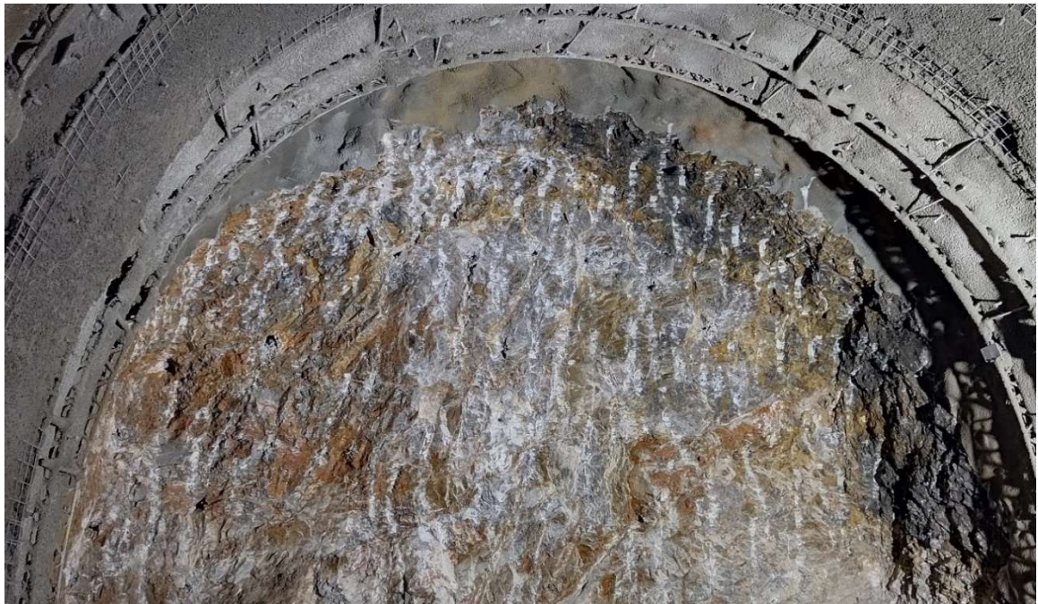
Slika 7-35. Iskop u vapnencu donje krede III. kategorije stijenske mase na stacionaži 35+115,00
