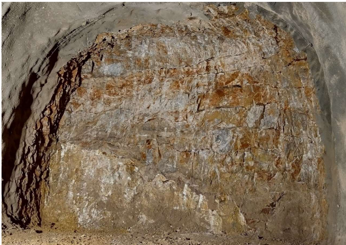
Slika 7-10. Kontakt pločastog vapnenca i rudistnog vapnenca gornje krede u III. kategorije stijenske mase na stacionaži 30+681,00
