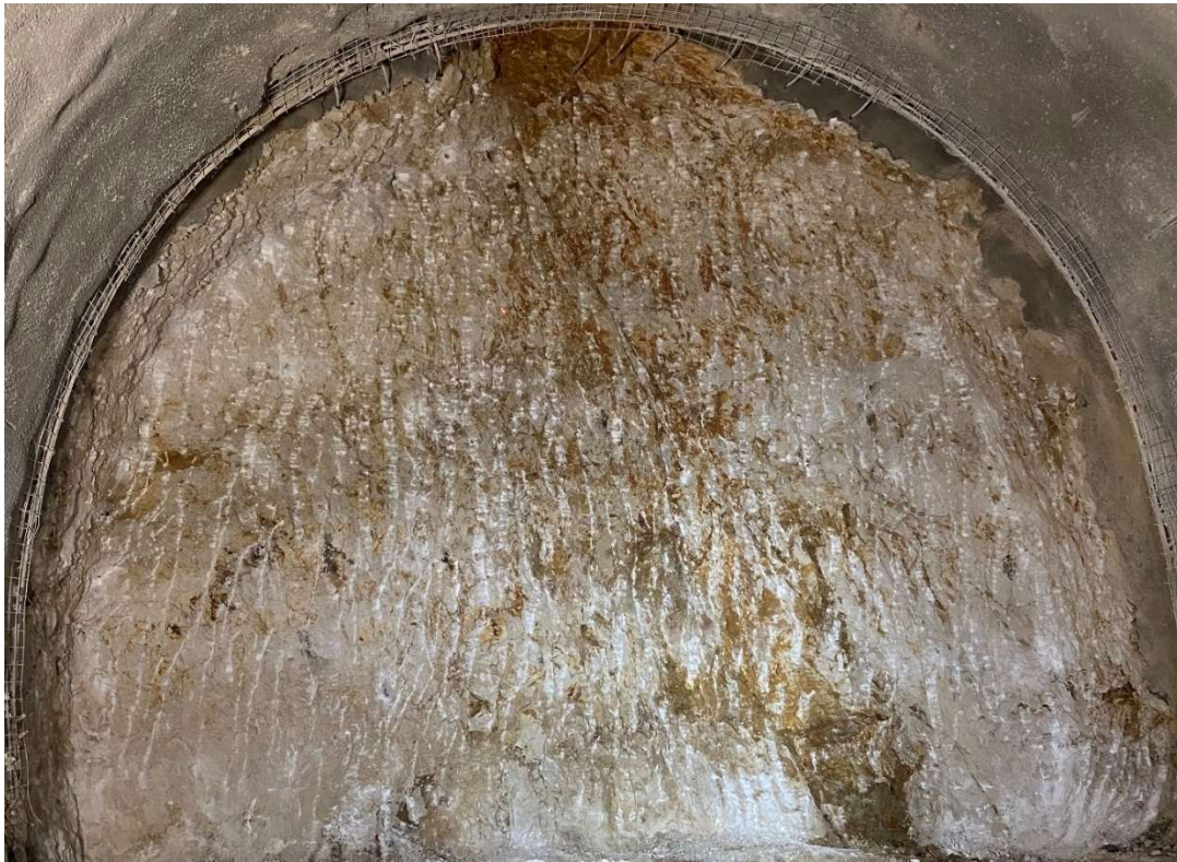
Slika 7-18. Iskop u rudistnom vapnencu gornje krede III. kategorije stijenske mase na stacionaži 31+094,00
