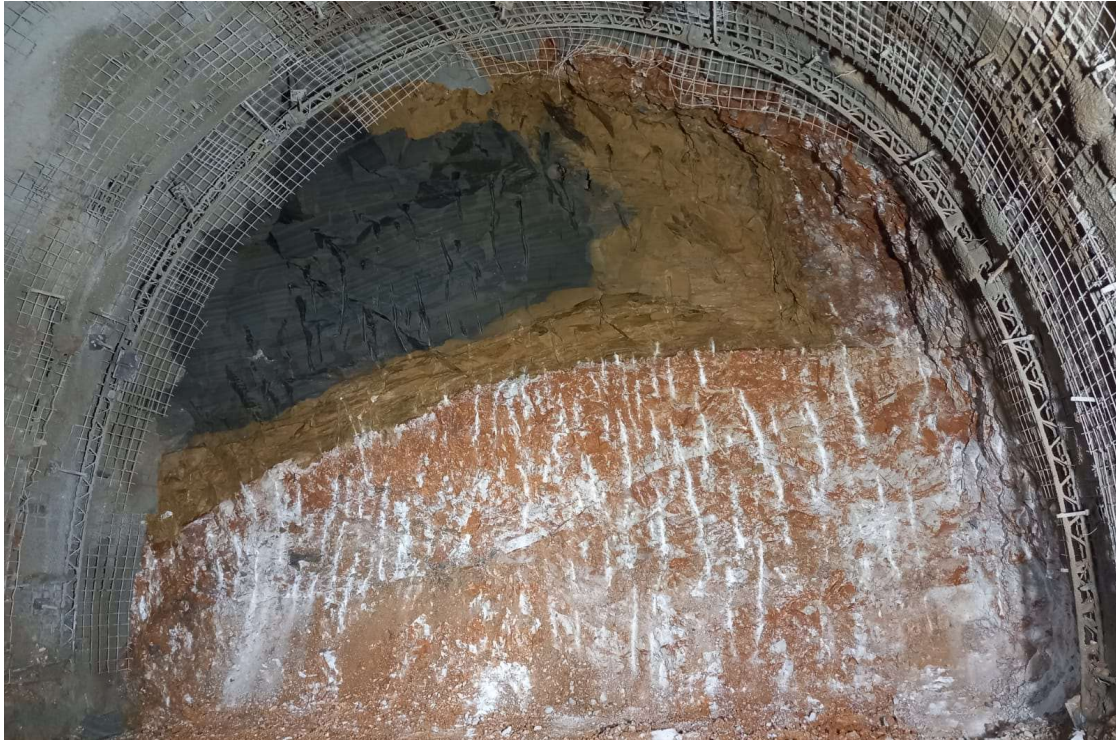
Slika 7-36. Iskop u vapnencu donje krede V. kategorije stijenske mase na st. 35+087,50
