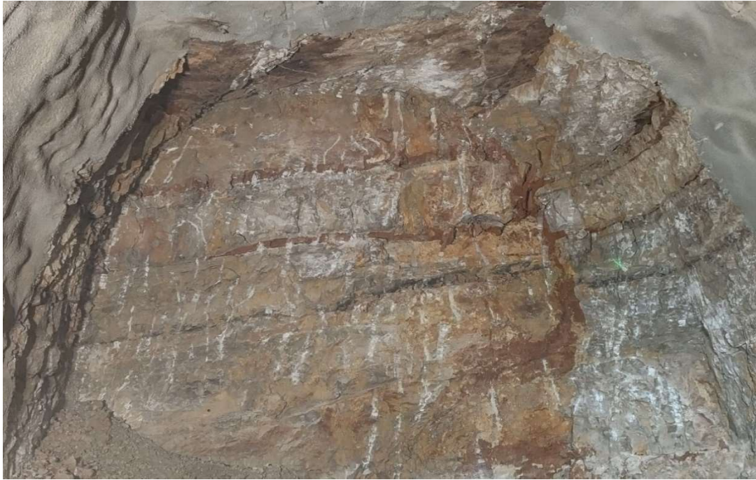
Slika 7-13. Iskop u pločastom vapnencu III. kategorije stijenske mase na stacionaži 30+712,00
