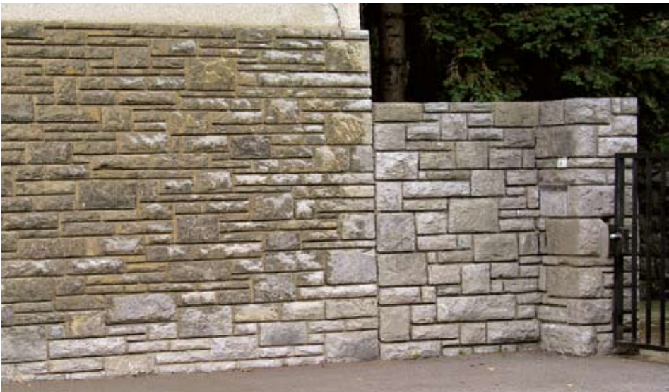
Sl. 6. Lipovečki vapnenac zahvaćen oksidacijom
