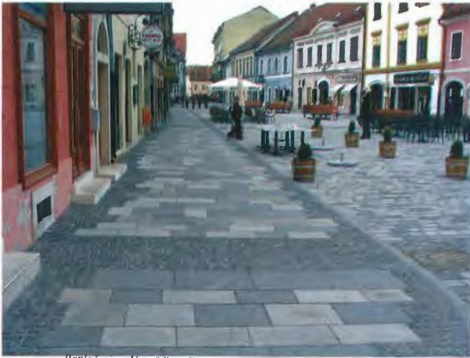
Popločenje u Varaždinu. Kamen obraden "anticato". (Gajeva ulica)
