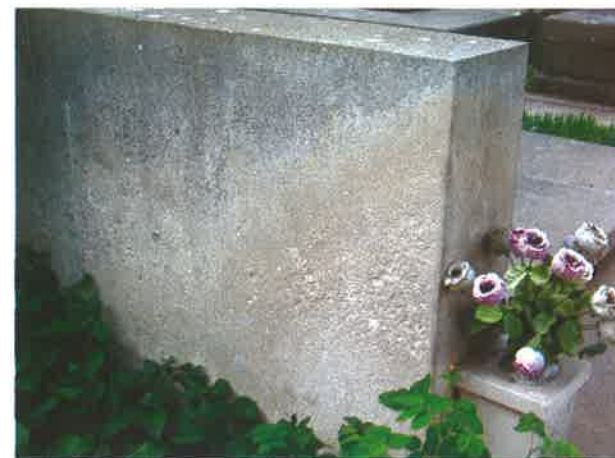
Sl. 5. Groblje u Pučišćima. Stražnja strana nadgrobne ploče djelomično je oštećena zbog nedovoljnog ispiranja kišom (2004.g.)
