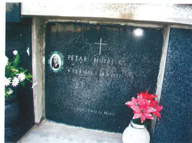
Sl. 6. Groblje povrh Baške na otoku Krku. Natkrivena ploča homogenog kamena magmatskog porijekla ujednačeno je oštećena. Udaljena je oko 200 m od mora te cca 40 m iznad površine mora. (2005.g.)
