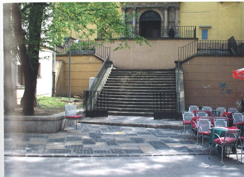
Prilaz crkvi Sv. Marije. Za pješačko kolničku konstrukciju je upotrebljen trahit-trahiandezit (novo), za pješačku stazu lipovečki kamen, ograda je izrađena od sivog granita, stube dijelom od litotamnijskog vapnenca a dijelom od lipovečkog, dok je portal izrađen od litotamnijskih i pjeskuljavih vapnenaca.
