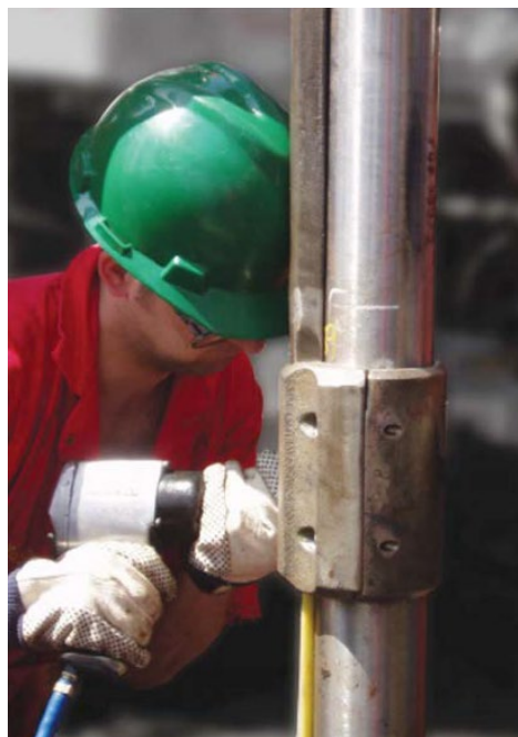
Slika 2-40. Ugradnja zaštitne ploče kontrolnog voda (Bellarby, 2009)
