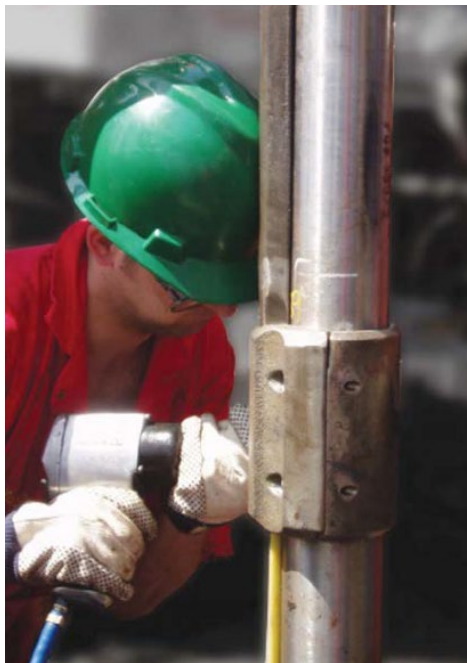
Slika 2-40. Ugradnja zaštitne ploče kontrolnog voda (Bellarby, 2009)
