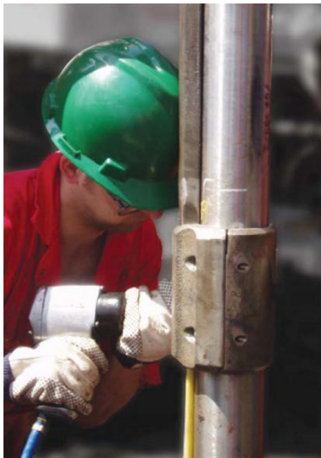
Slika 2-40. Ugradnja zaštitne ploče kontrolnog voda (Bellarby, 2009)
