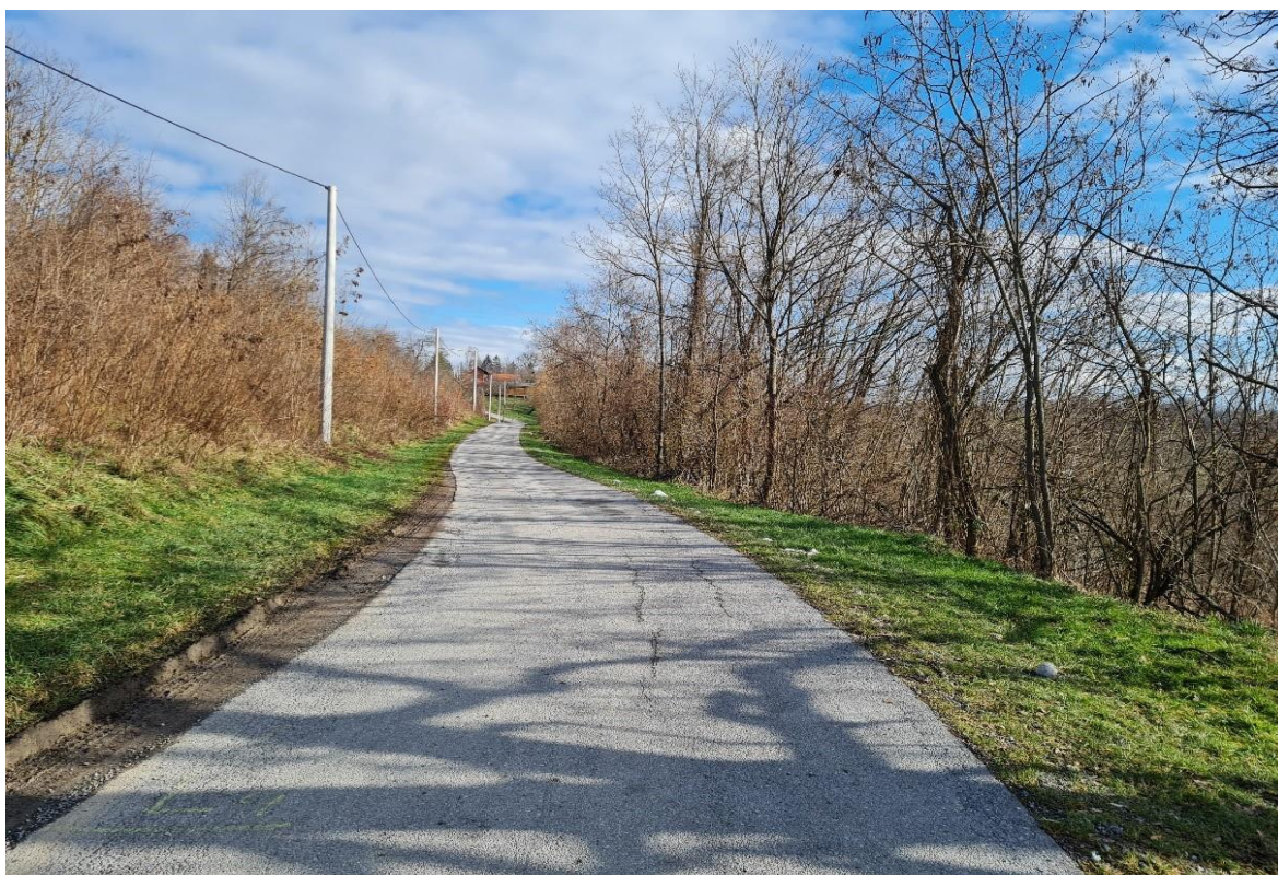
Slika 4-5. Lokacija 4 oko stacionaže 1+270 na županijskoj cesti ŽC 4043
