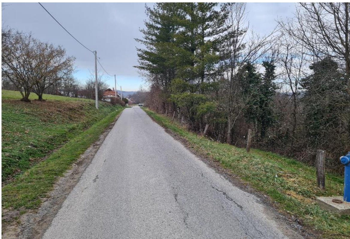
Slika 4-6. Lokacija 5 oko stacionaže 1+500 na županijskoj cesti ŽC4043
