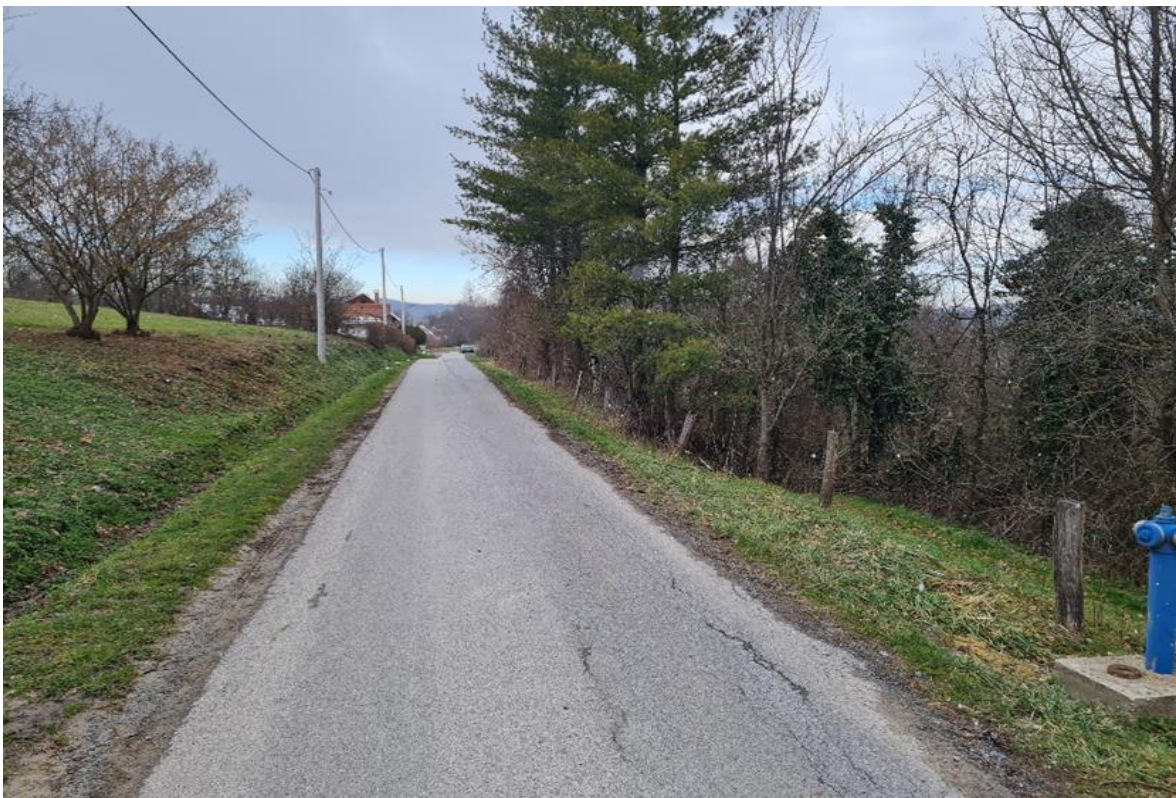
Slika 4-6. Lokacija 5 oko stacionaže 1+500 na županijskoj cesti ŽC4043
