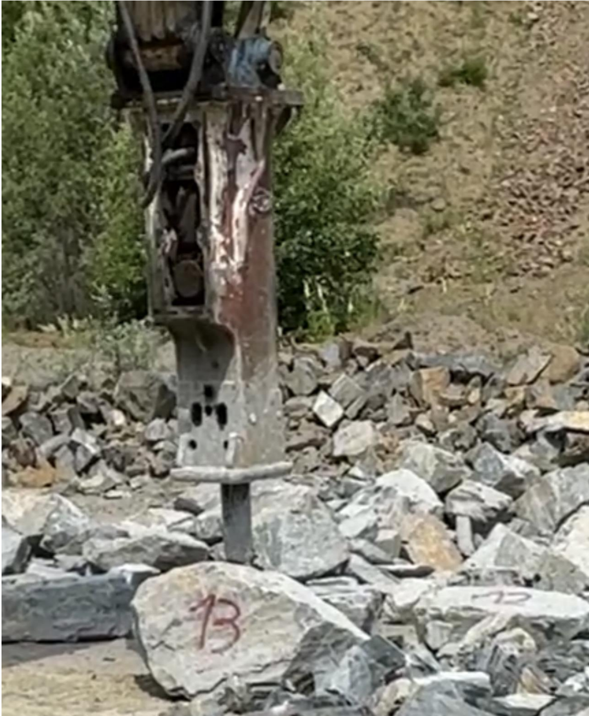
Slika 3-7. Pozicioniranje čekića prije usitnjavanja vangabaritnog bloka broj 13
