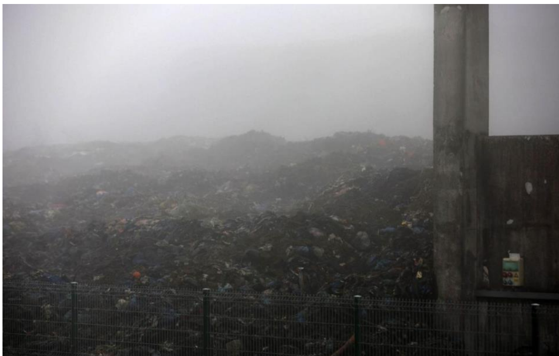
Slika 3-10. Klizište na odlagalištu Prudinec, prosinac 2023.godine (Karaklaš Jakubin et al., 2023)
