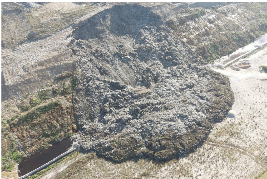
Slika 3-8. Klizište na odlagalištu Prudinec, studeni 2023.godine (Mitrović, 2023)
