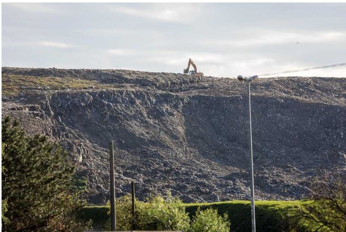
Slika 3-9. Klizište na odlagalištu Prudinec, studeni 2023.godine (Mitrović, 2023)
