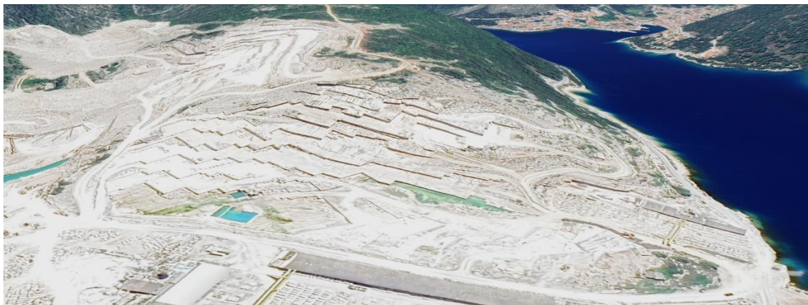
Slika 4-1. Ležište Punta Barbakan, Pučišća (Google Earth, 2024.)
