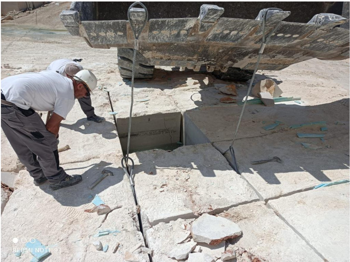
Slika 4-5. Namještanje sajli za podizanje bloka
