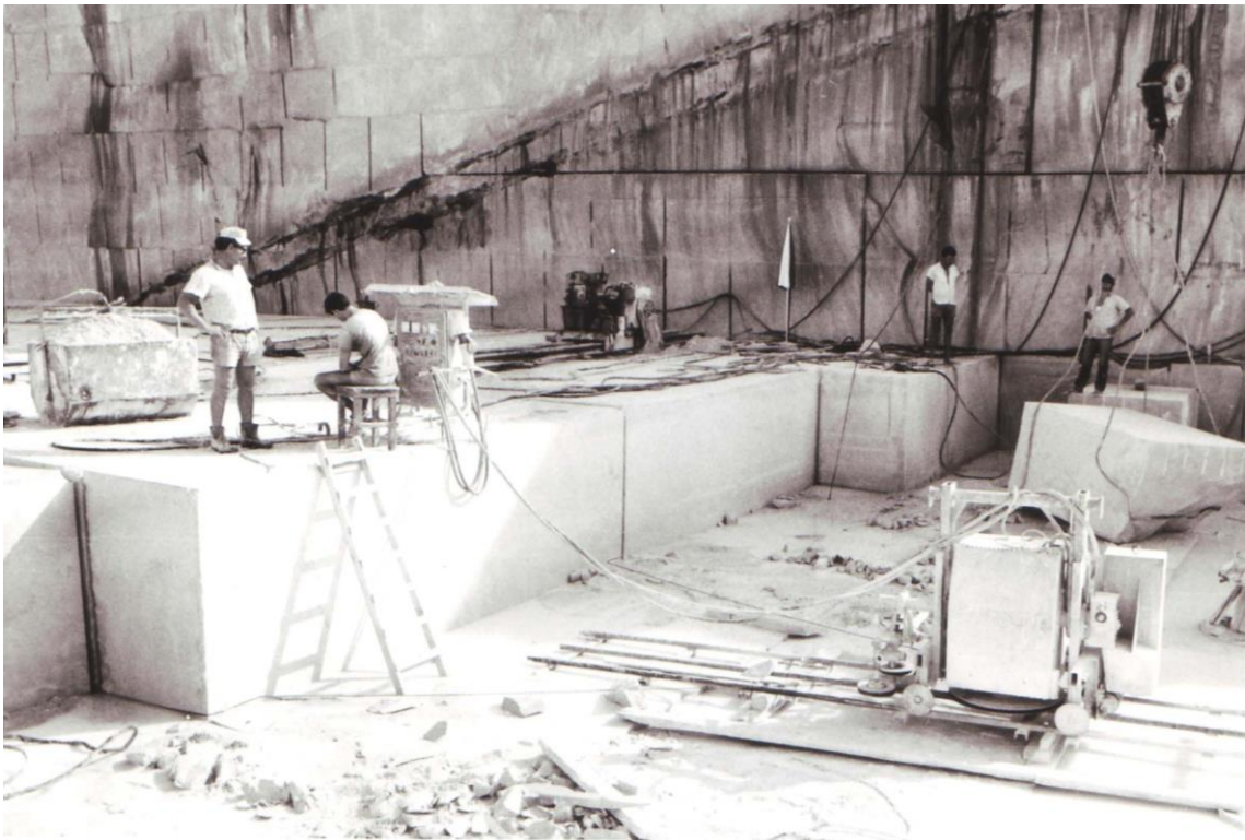
Slika 3-11. Izrada vertikalnih rezova lančanom pilom u dubinskom kamenolomu Sivac (Martinić, 1988.)
