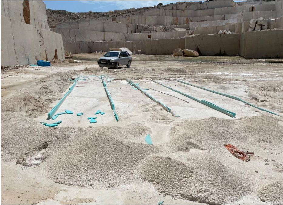
Slika 4-3. Ubacivanje stiradura zbog zaštite rezova
