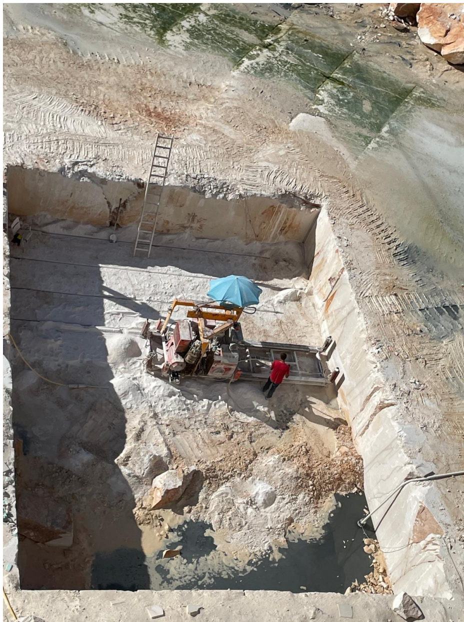
Slika 4-8. Izrada paralelnih vertikalnih rezova za napredovanje u nižu etažu
