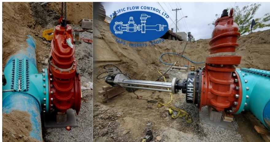
Slika 6-8. "Hot tapping" uređaj (Pacific Flow Control, 2021)
