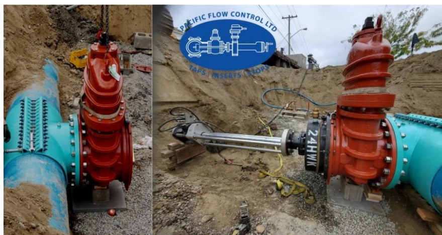
Slika 6-8. "Hot tapping" uređaj (Pacific Flow Control, 2021)
