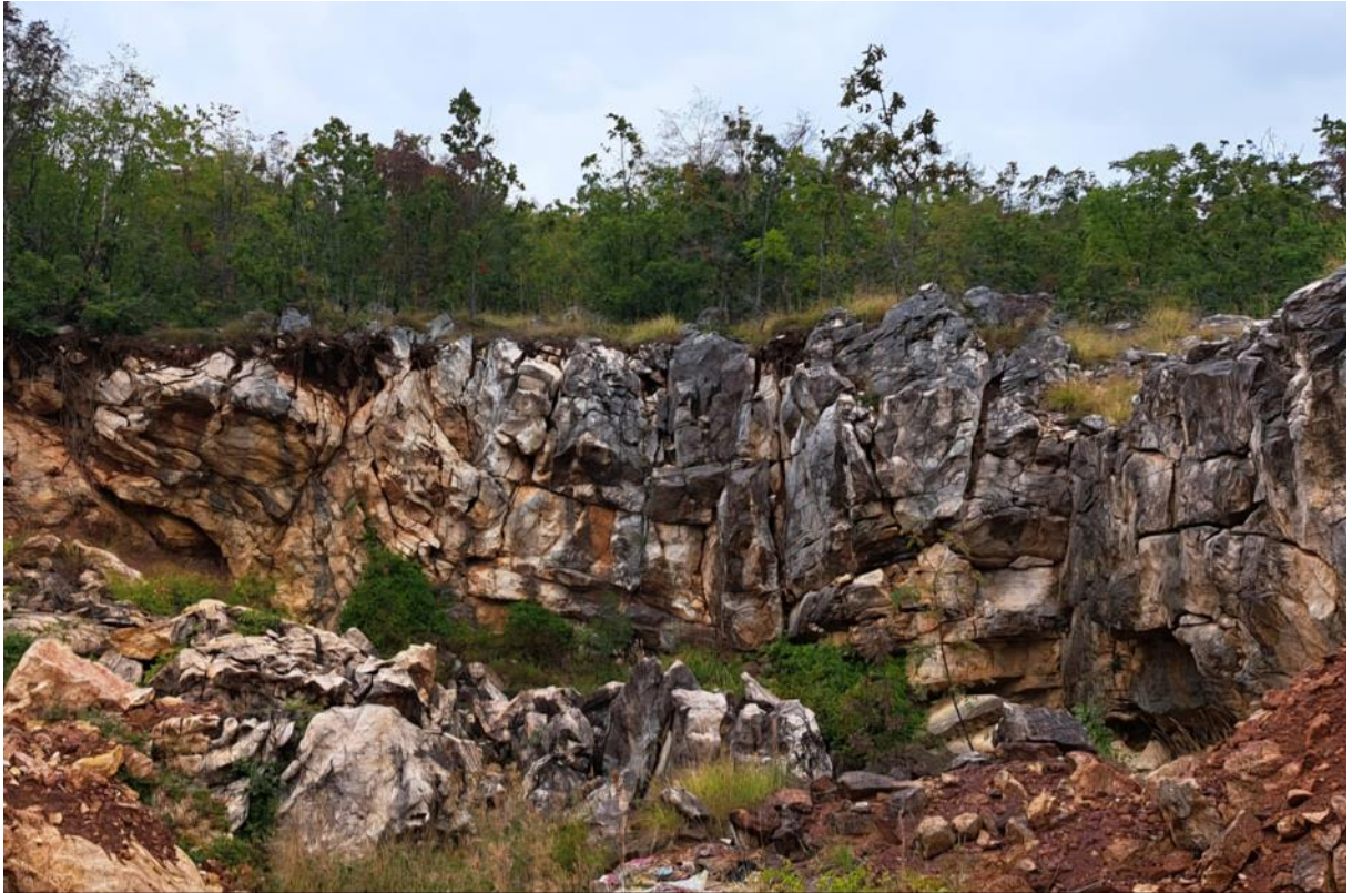
SLIKA 1-1. KOLAPSNA STRUKTURA U KROVINSKIM NASLAGAMA LEŽIŠTA NA LOKALITETU SOBAČ
