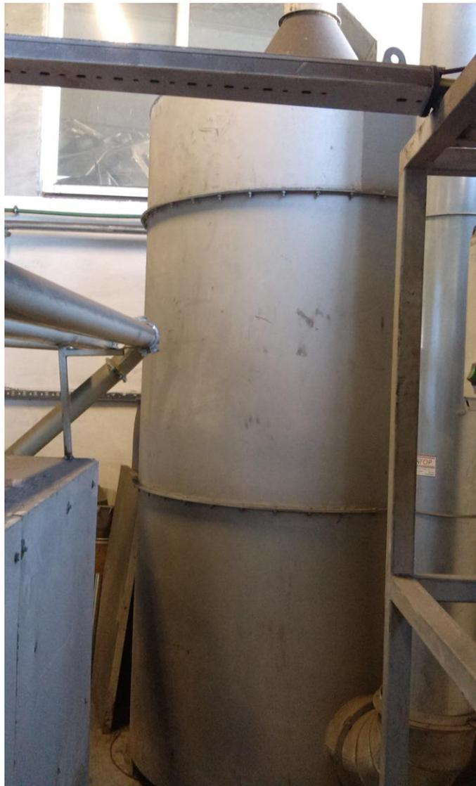
Slika 3-8. Uređaj za filtraciju zraka s aktivnim ugljenom
