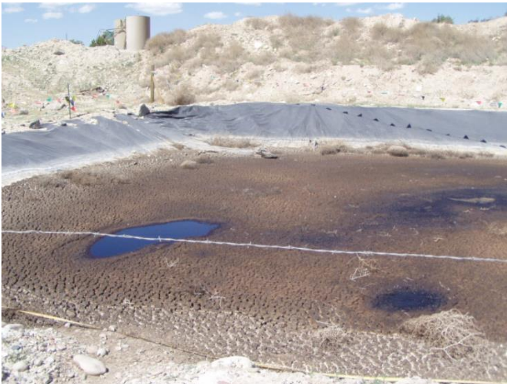
Slika 3-6. Pomoćna otpadna jama nakon isparavanja fluida (Ramirez, 2009)
