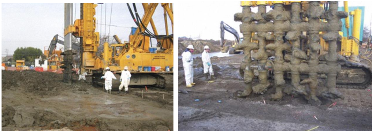
Slika 3-8. In-situ solidifikacija/stabilizacija: primjer miješanja otpadnog materijala onečišćenog arsenom stabilizirajućim sredstvom (sulfatno-cementnim muljem) (Sobota, 2014)
