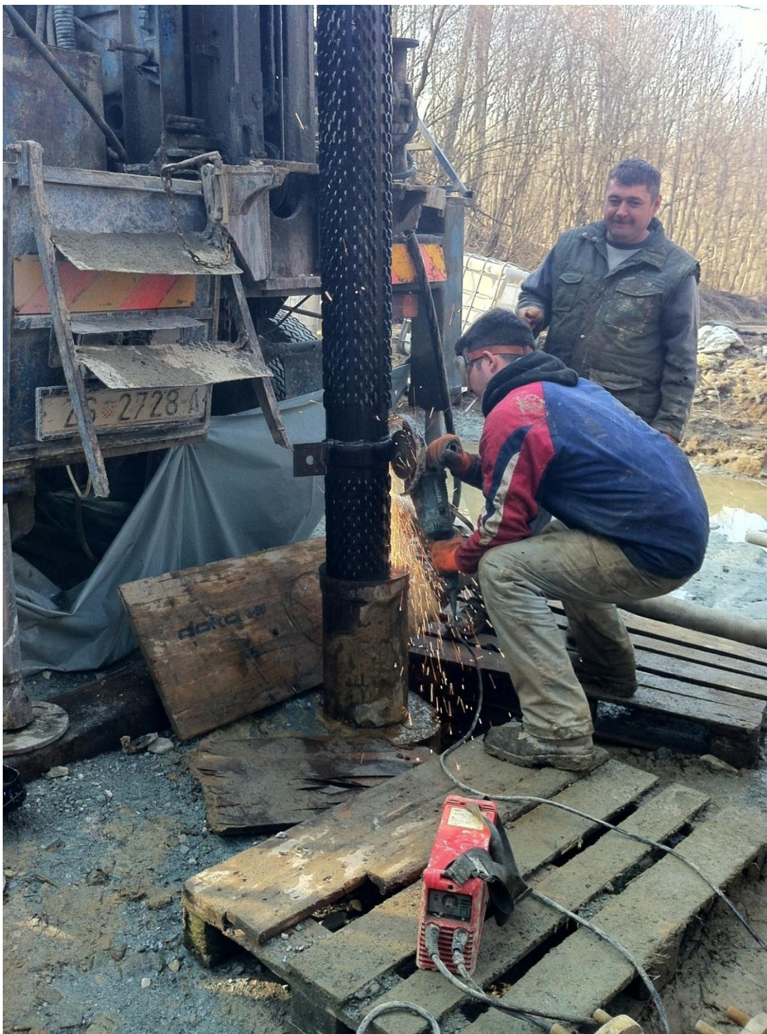
Slika 5-6. Ugradnja sita.
